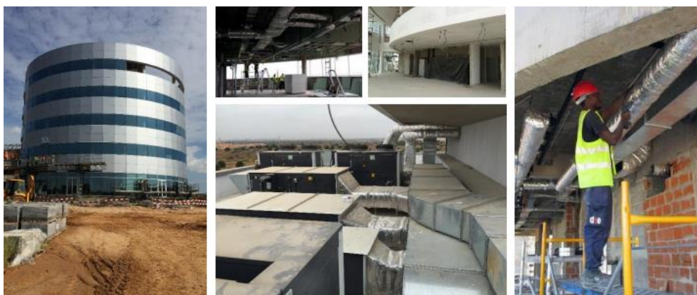
Figura 6 - Exemplo de Obras da dte
