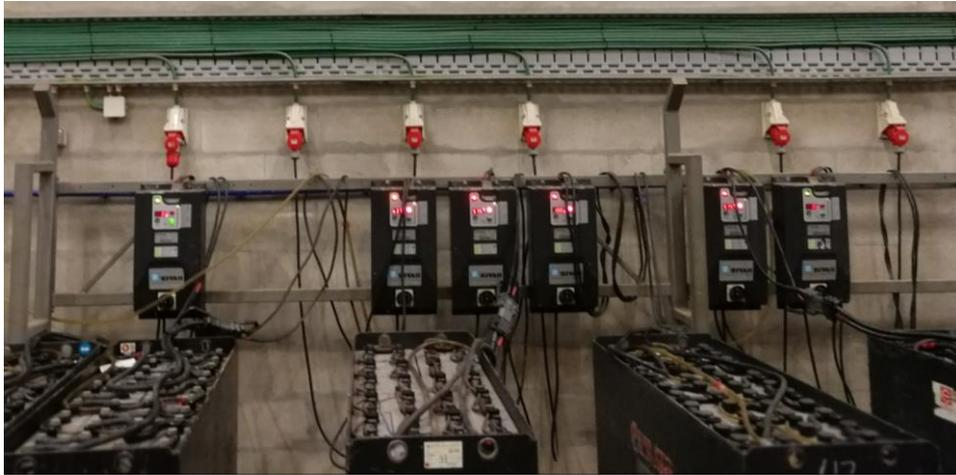
*Figura 18: Disposição dos carregadores de baterias de retráteis nos bastidores da zona de baterias do APA*
