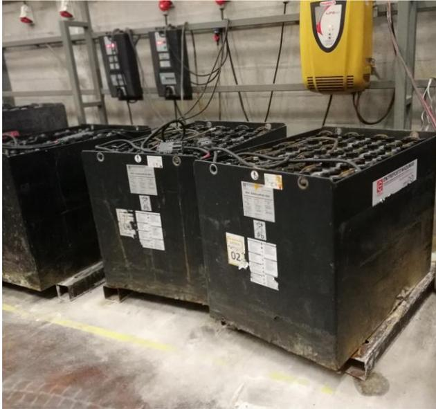
*Figura 20: Método de colocação de baterias de convencionais à carga na zona de baterias do APA*
