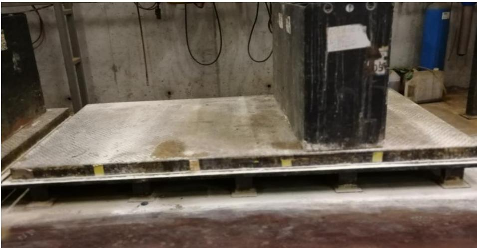
*Figura 19: Suporte das baterias de retráteis situado na zona de baterias do APA*
