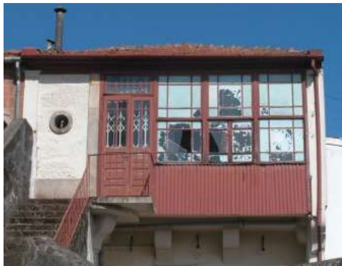
Figura 2: Ampliação / reabilitação de varanda no Porto.
