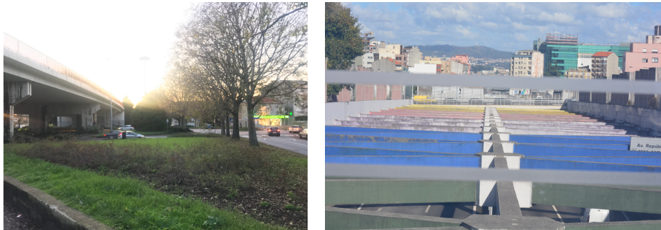
9- Fotografias de obras de arte especiais: Aterro do Amial no Porto e Túnel da Av. da República em Vila Nova de Gaia
