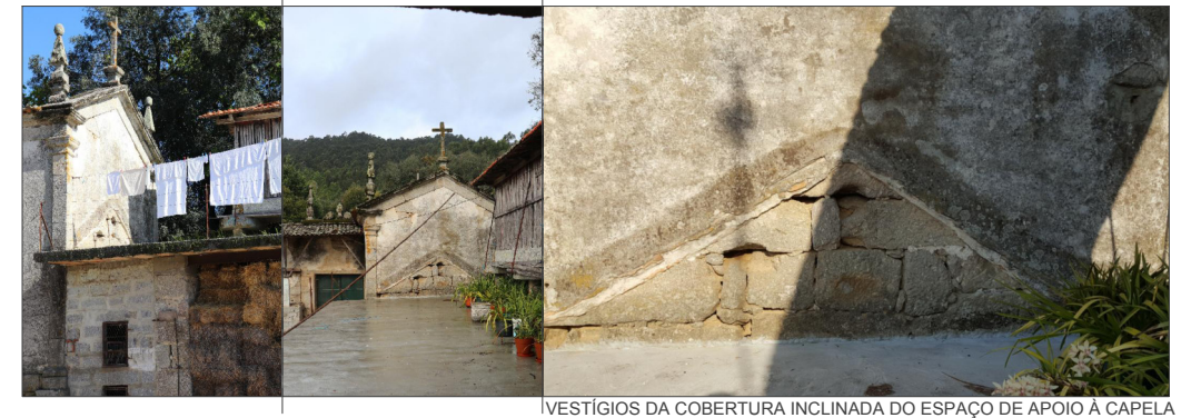
VESTÍGIOS DA COBERTURA INCLINADA DO ESPAÇO DE APOIO À CAPELA
