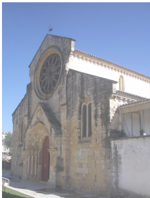
Figura 58 - Vista exterior do alçado principal de Santa Maria do Olival
