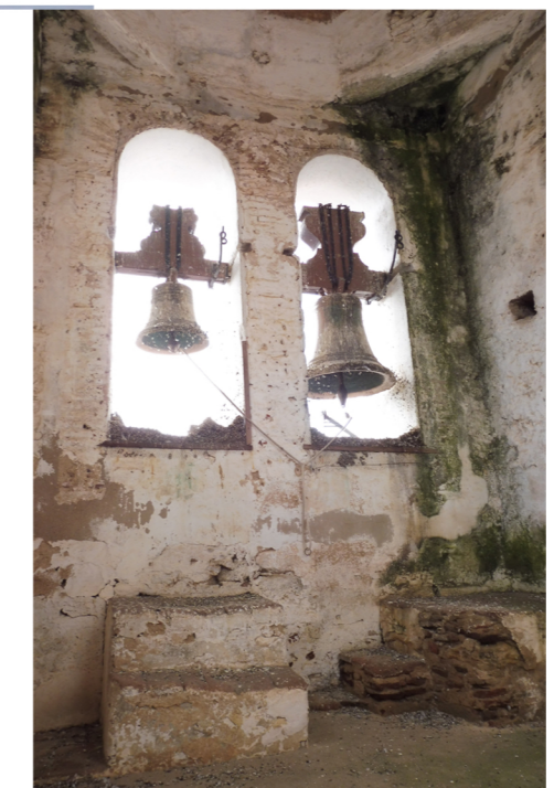
PAREDES INTERIORES DA TORRE
