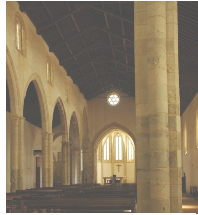
Figura 106 – Interior da Igreja do Convento de Santa Clara, Santarém
