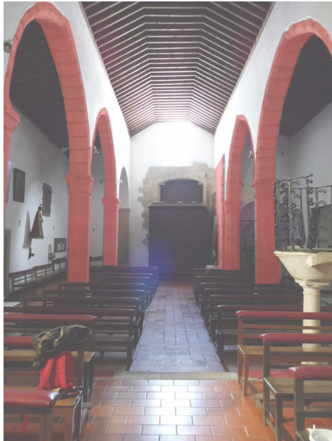
Figura 55 - Vista interior de São Pedro - Arcos quebrados
