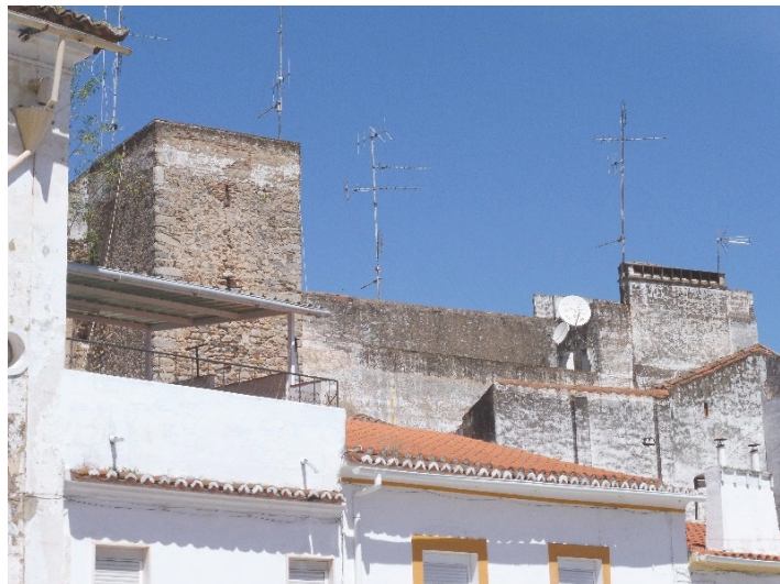
Figura 16 - Torre e troço de muralha que sobreviveram à expansão e evolução de Elvas - próxima da torre sineira do caso de estudo.
