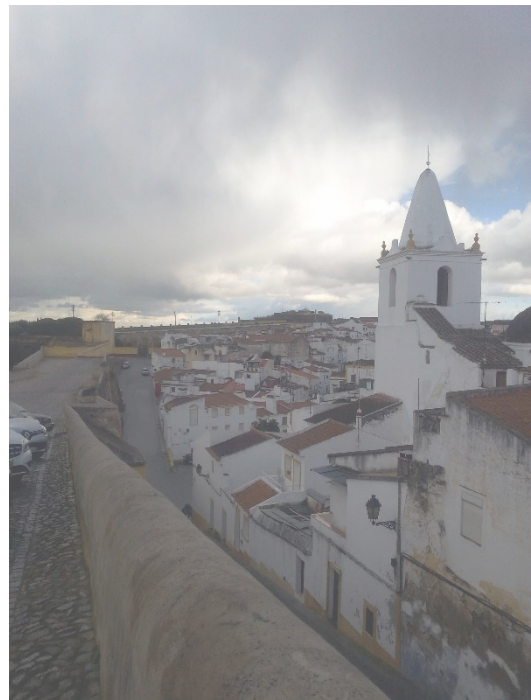
Figura 71 - Exterior do coruchéu
