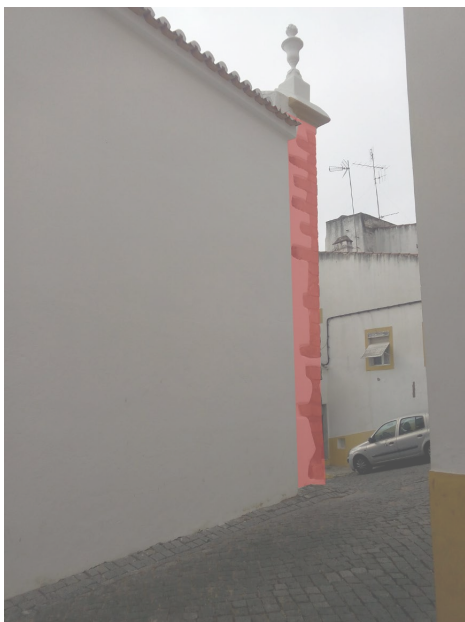
Figura 53 - Vestígio da parede da torre na fachada principal pelo exterior.
