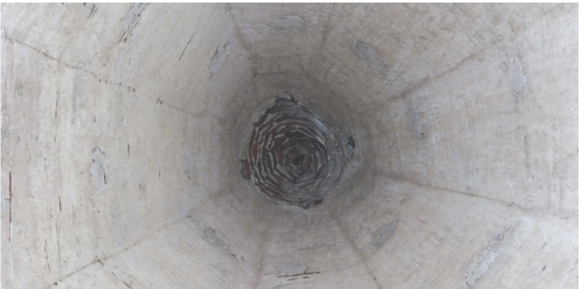
Figura 5 - Remate interior do Coruchéu cónico que remata a torre sineira
