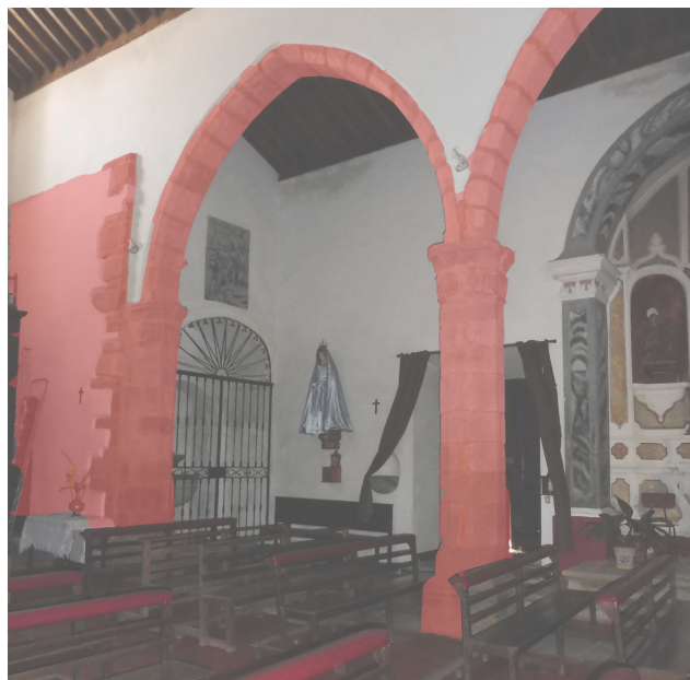
Figura 54 - Arcos quebrados e parede da torre, perspetiva interior
