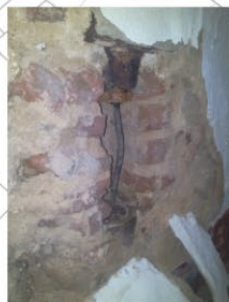
2 - parede de tijolo pertencente ao acesso a uma porta lateral e a uma das sacristias
