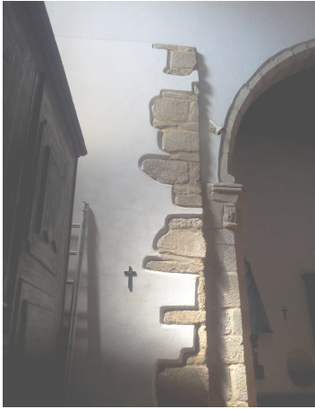
Figura 51 - Vestígios da parede da torre na fachada principal da igreja e que pode nunca ter sido concluída.
