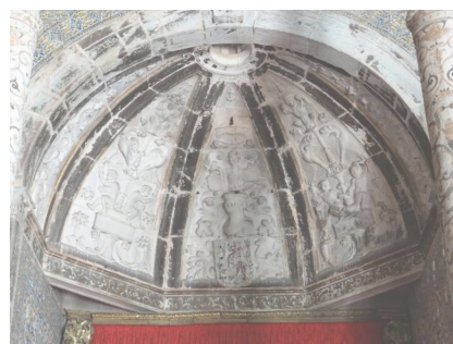
Figura 66 - Interior da cúpula da Igreja das Dominicadas em Elvas
