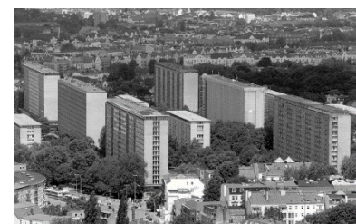
Fig. 84 – Primeiro conjunto de edifícios de habitação colectiva na Alemanha, o Grindelberg de Hamburgo, construído em 1957.
