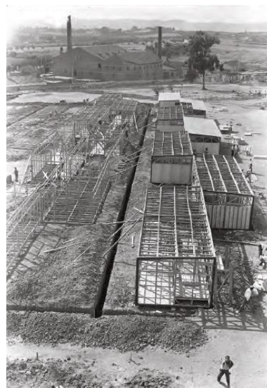
Fig. 143 – Construção das Casas Desmontáveis da Quinta da Calçada, Lisboa, 1938
