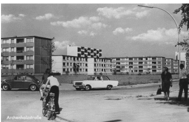
Fig. 101 – Conjunto de edifícios em Billstedt, Alemanha, s/d
