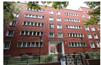
Fig. 34 – Edifício HBM construído na praça Dufourmantelle, França, data actual
