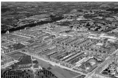
Fig. 148 – Vista aérea do bairro de Casas de Renda Económica de Alvalade, Lisboa, 1945
