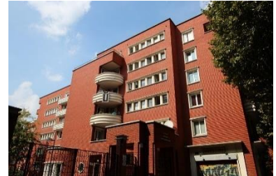
Fig. 33 – Edifício HBM construído na praça Dufourmantelle, França, data actual
