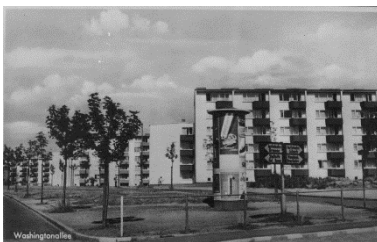
Fig. 102 – Conjunto de edifícios em Billstedt, Alemanha, s/d
