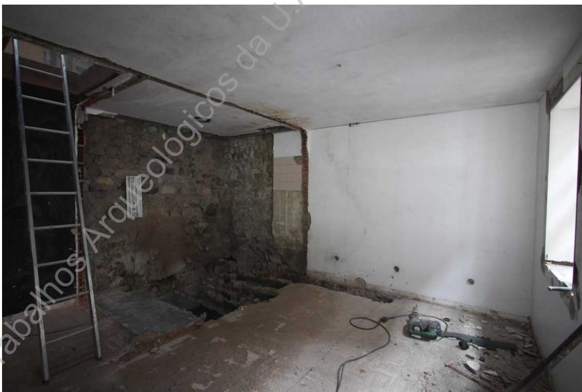
Foto 2 – Registo dos alçados internos dos muros que delimitam a área intervencionada após retirada do reboco.
