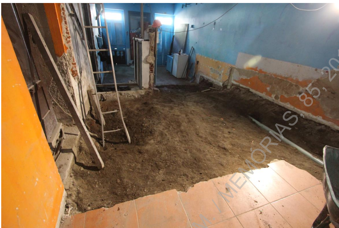
Foto 3 – Remoção do pavimento onde foi realizada a sondagem de diagnóstico.
