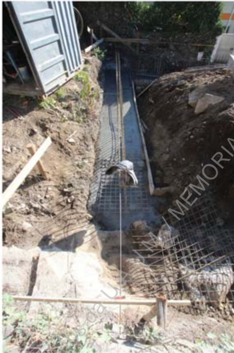
Foto 54 – Acompanhamento da implantação de cofragem para sapatas, área 1.
