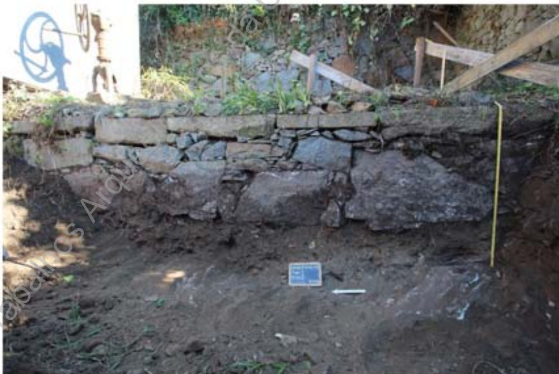
Foto 4 – Muro de contenção de terras (UE0003), área 1.
