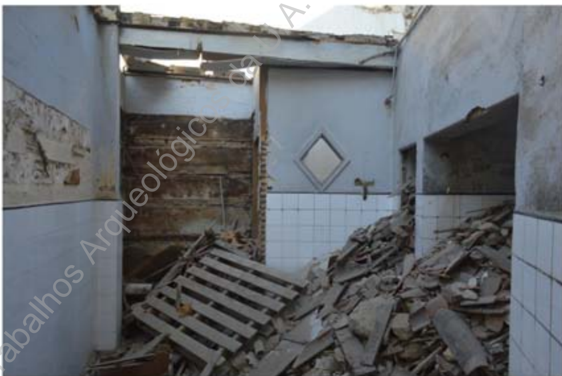
Foto 17 – Acompanhamento dos trabalhos de demolição, área 2.
