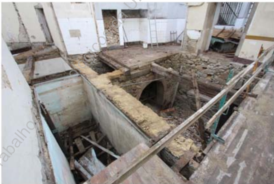
Foto 26 – Levantamento do edificado interno da habitação, área 2.
