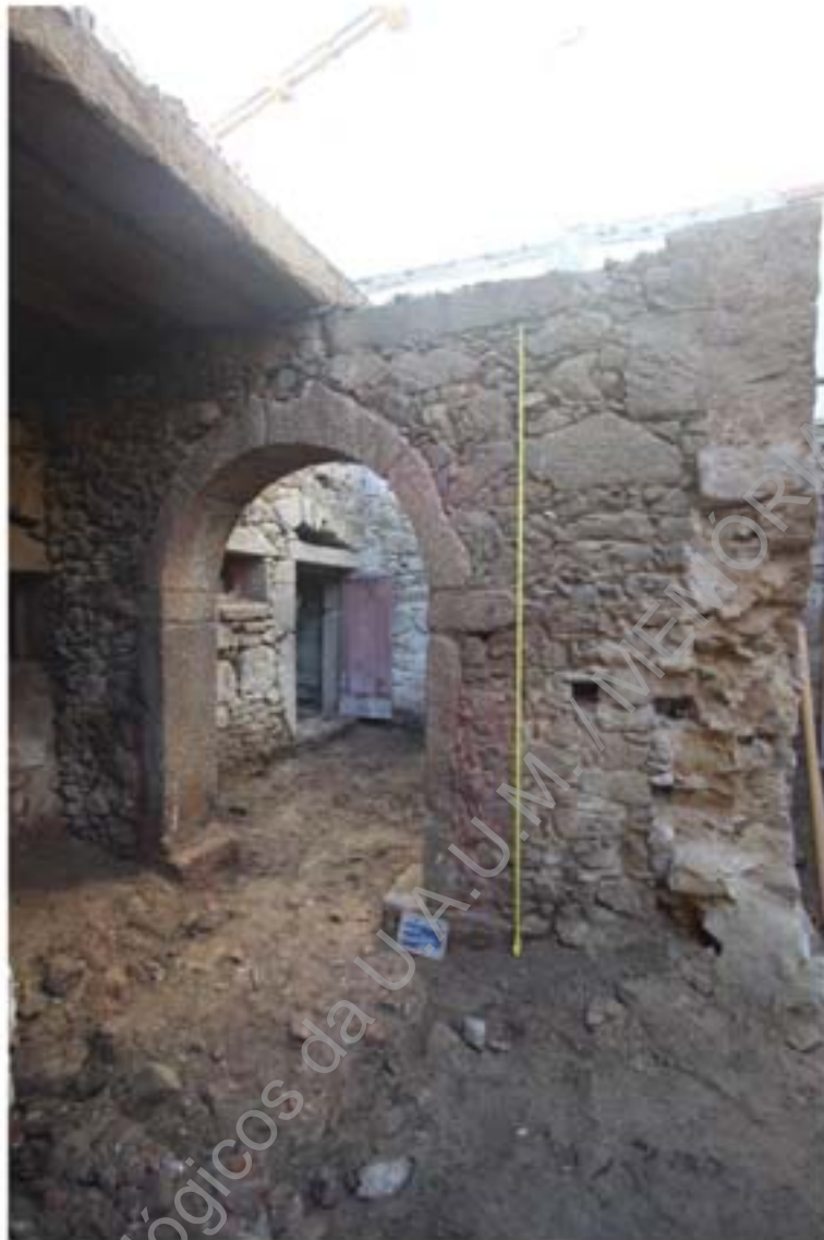
Foto 24 – Levantamento do edificado interno da habitação UE0046, área 2.
