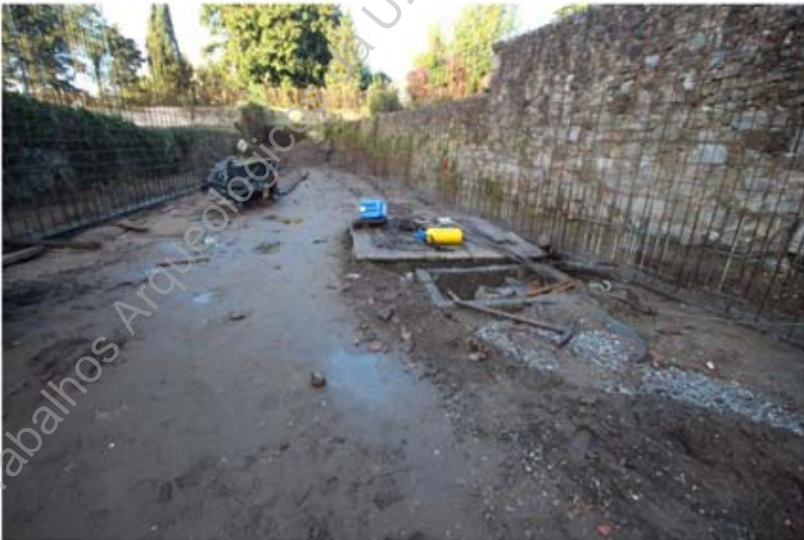
Foto 40 – Acompanhamento dos trabalhos de decapagem mecânica, área 1.
