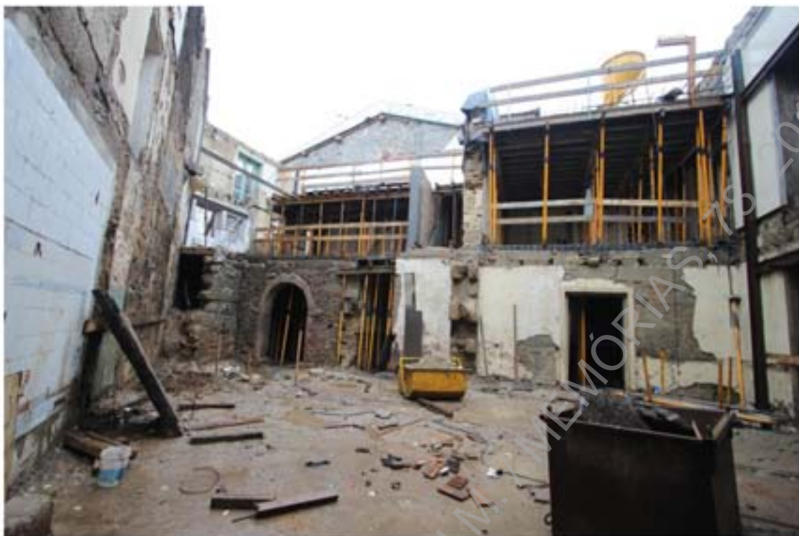
Foto 30 – Levantamento do edificado interno da habitação (UEs0022, 0042, 0046), área 2.
