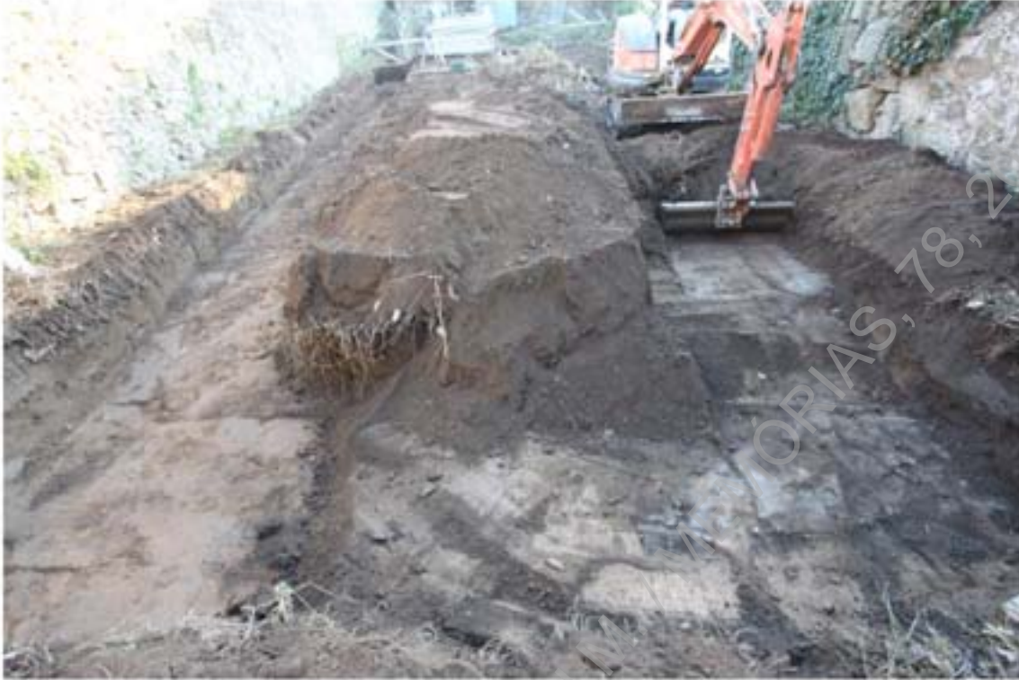
Foto 42 – Acompanhamento dos trabalhos de decapagem mecânica, área 1.
