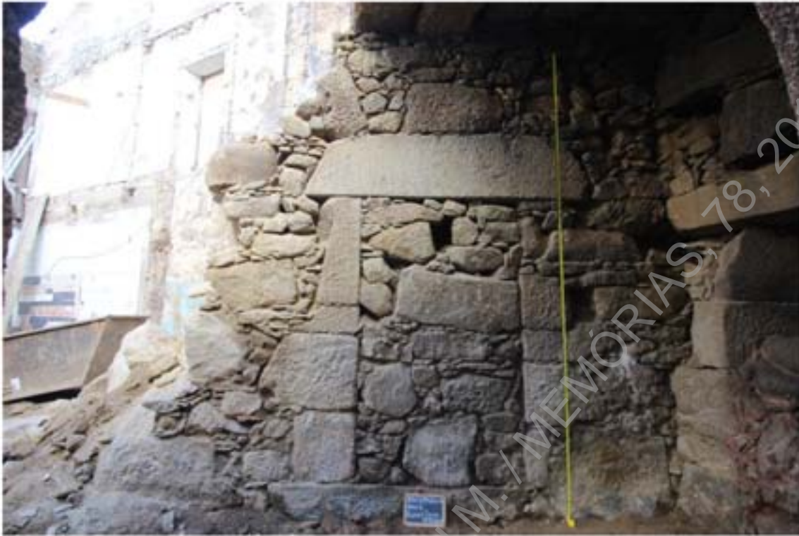
Foto 28 – Levantamento do edificado interno da habitação (UE0023), área 2.
