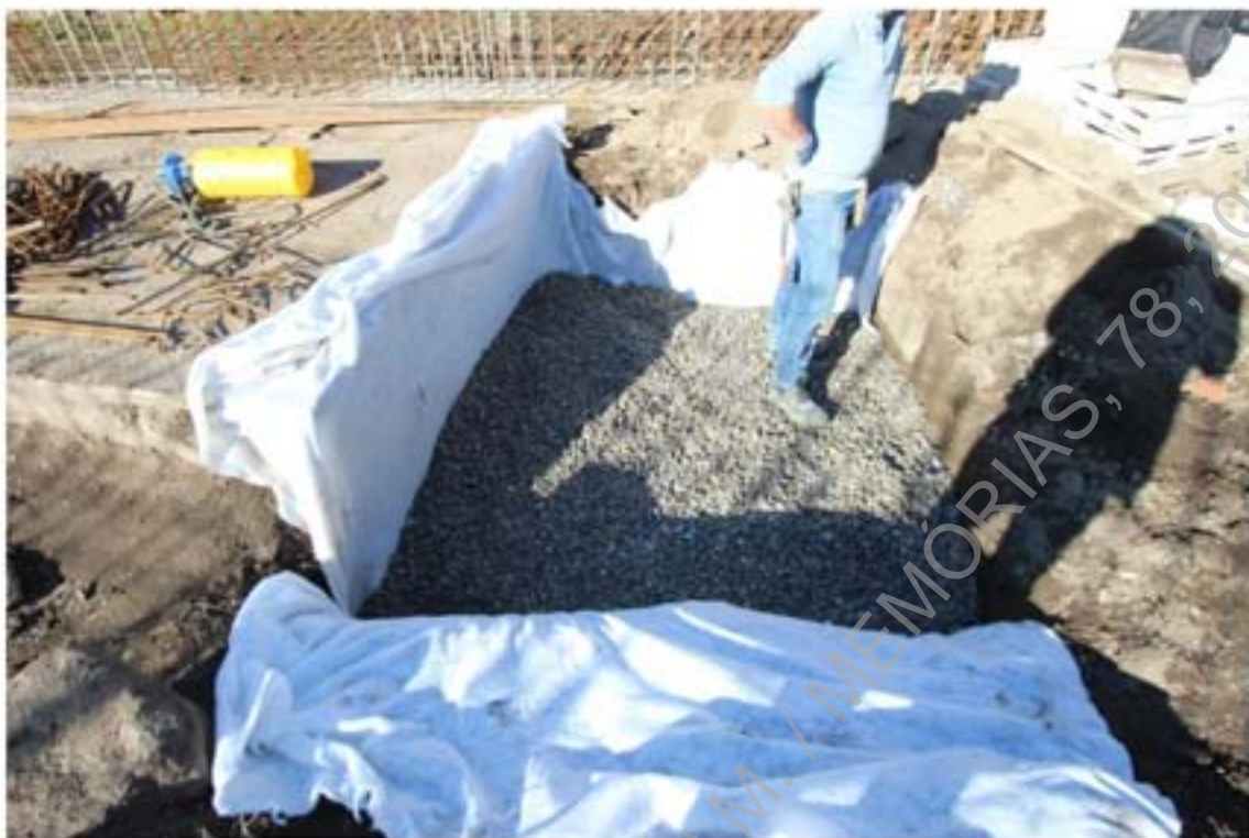
Foto 55 – Camada de geotêxtil e brita para proteção das ruínas, área 1.
