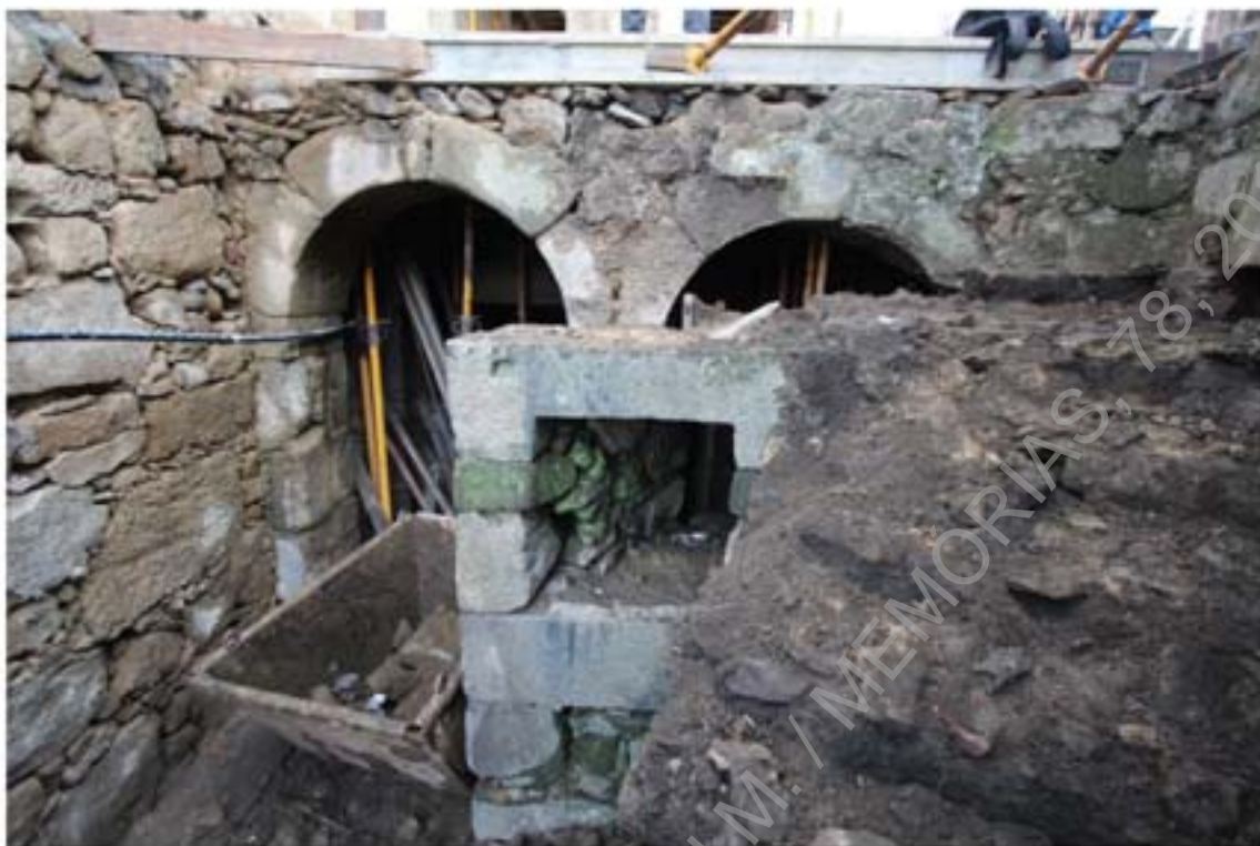
Foto 25 – Levantamento do edificado interno da habitação, área 2.
