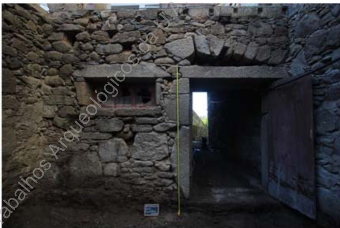
Foto 23 – Levantamento do edificado interno da habitação UE0042, área 2.
