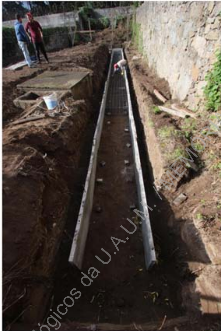
Foto 52 – Acompanhamento da implantação de cofragem para sapatas, área 1.
