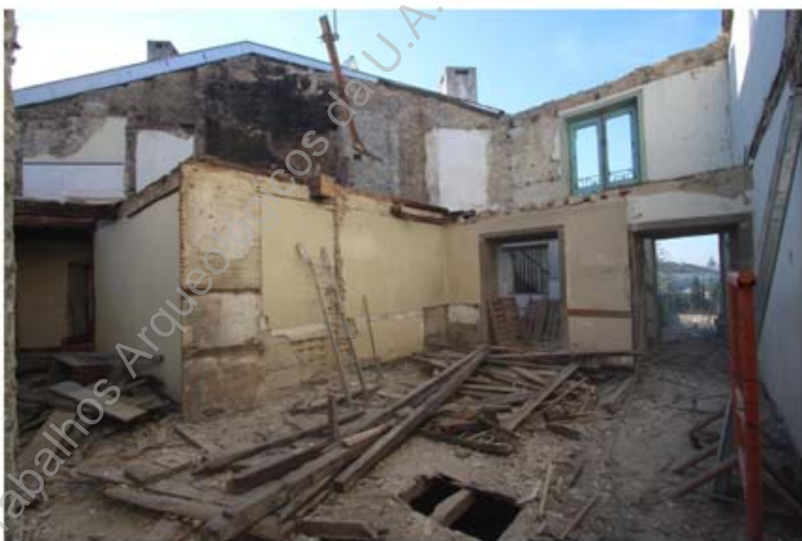
Foto 19 – Acompanhamento dos trabalhos de demolição, área 2.
