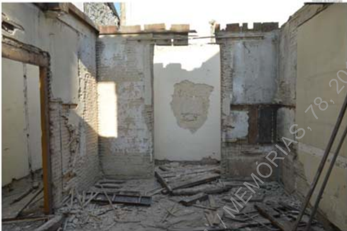
Foto 16 – Acompanhamento dos trabalhos de demolição, área 2.
