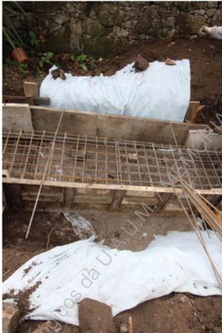
Foto 53 – Acompanhamento da implantação de cofragem para sapatas, área 1.
