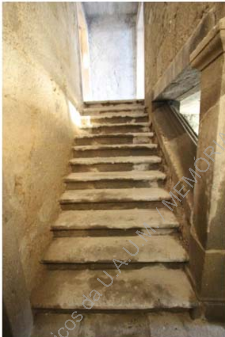
Foto 6 – Escadas internas da habitação (UE0040), área 2.
