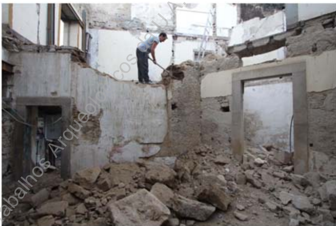
Foto 21 – Acompanhamento dos trabalhos de demolição, área 2.
