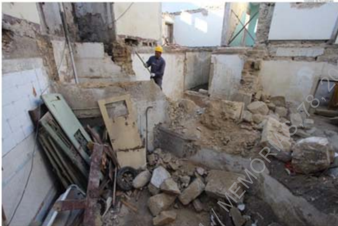
Foto 22 – Acompanhamento dos trabalhos de demolição, área 2.
