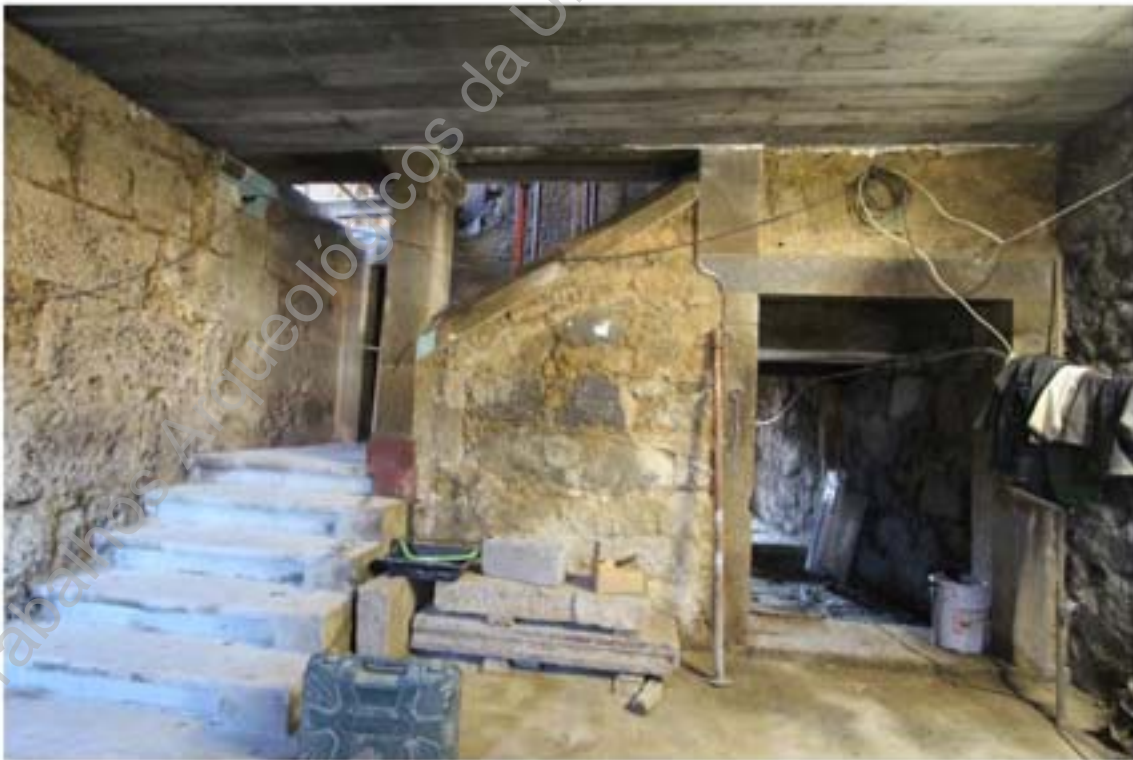
Foto 29 – Levantamento do edificado interno da habitação (UEs0040, 0044, 0045), área 2.
