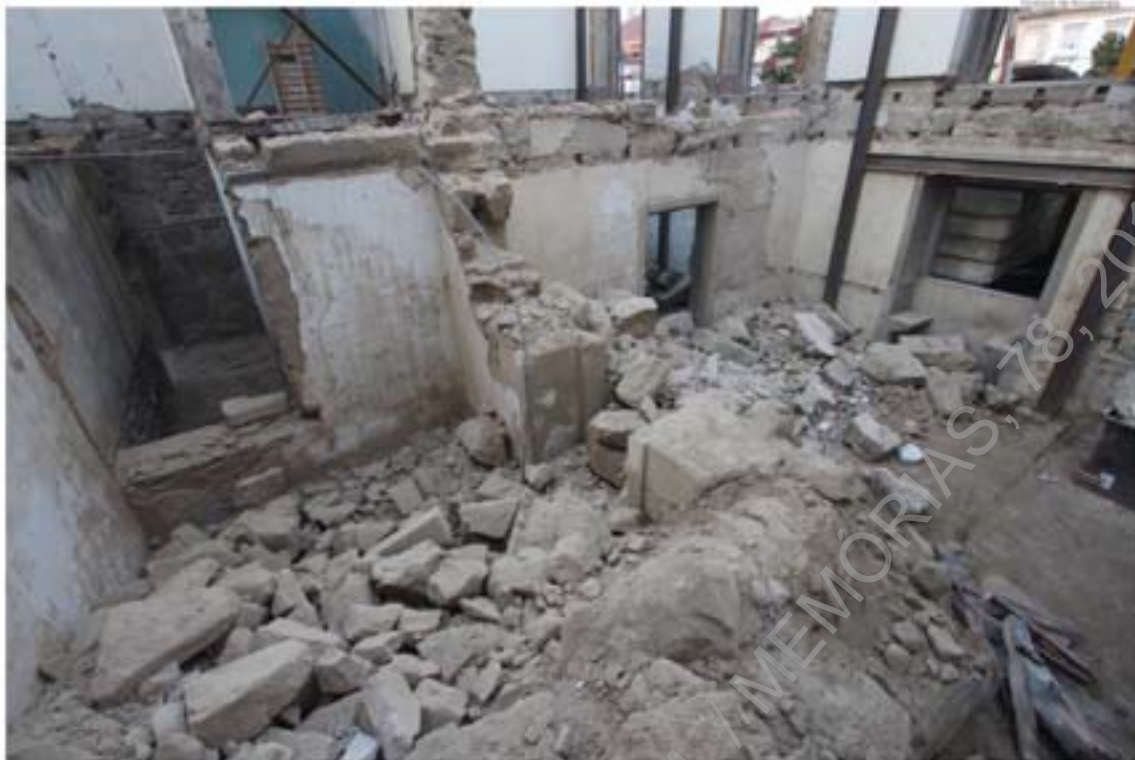
Foto 18 – Acompanhamento dos trabalhos de demolição, área 2.
