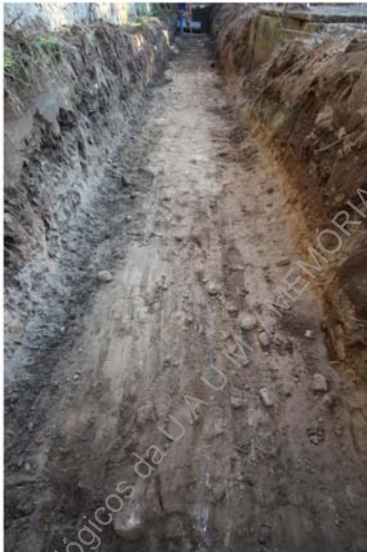
Foto 43 – Acompanhamento dos trabalhos de decapagem mecânica, área 1.
