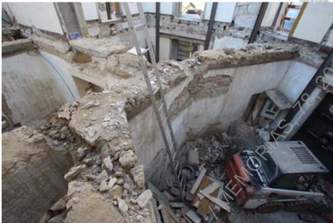
Foto 20 – Acompanhamento dos trabalhos de demolição, área 2.
