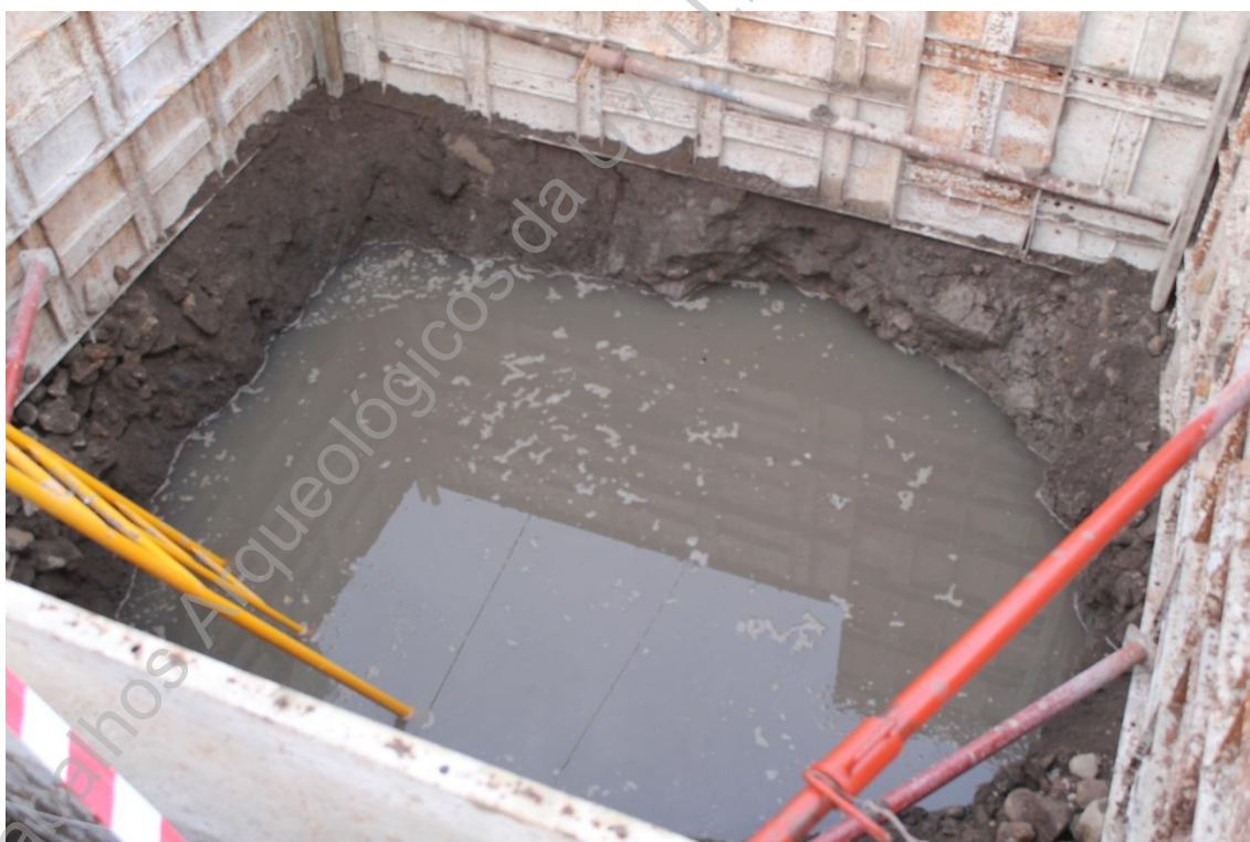
Foto 12 - (IMG_3164) – Aspeto de inundação de sondagem.
