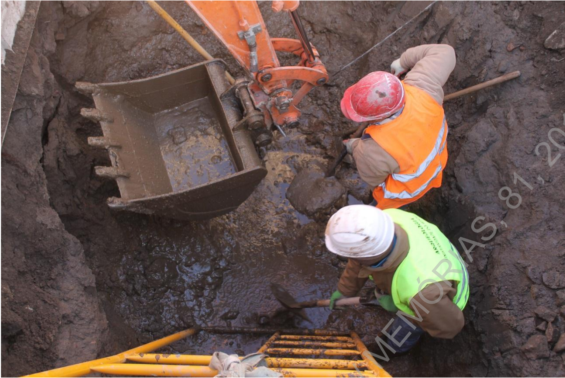
Foto 13 - (IMG_3170) – Aspeto de limpeza de sondagem.
