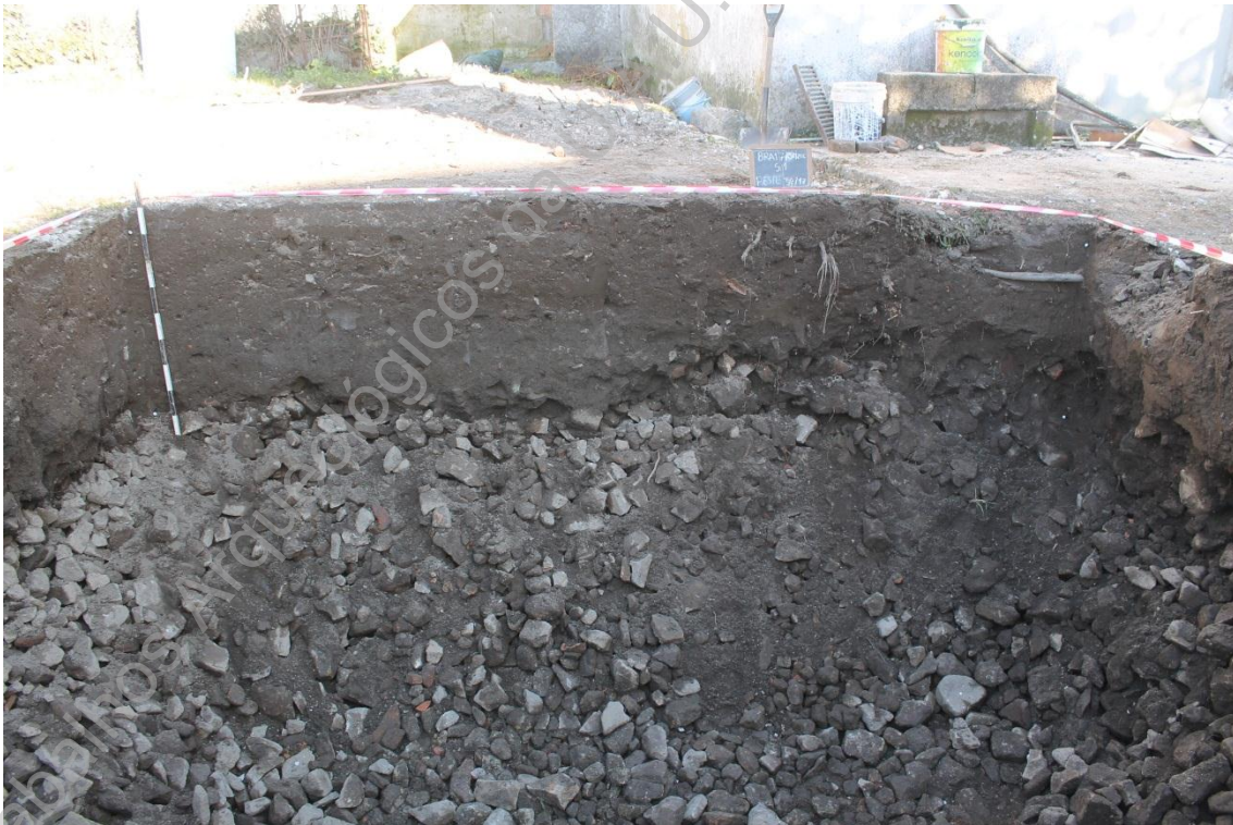
Foto 10 - (IMG_3138) – Perfil este, aspeto de zona superior.
