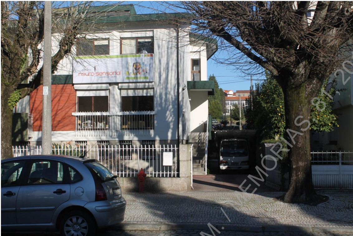
Foto 1 - (IMG_3083) - Aspeto geral de entrada de Centro Neuro sensorial (S/N).
