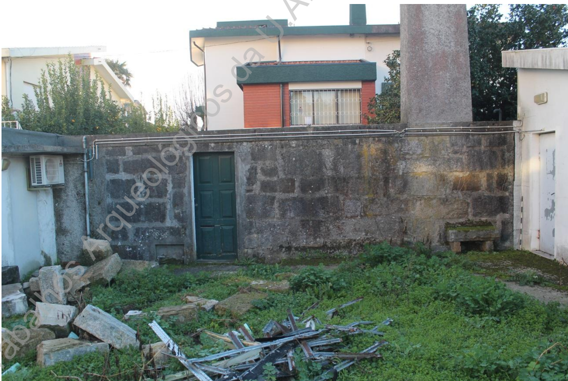
Foto 2 - (IMG_3041) - Aspeto de área de intervenção antes do início dos trabalhos (N/S).
