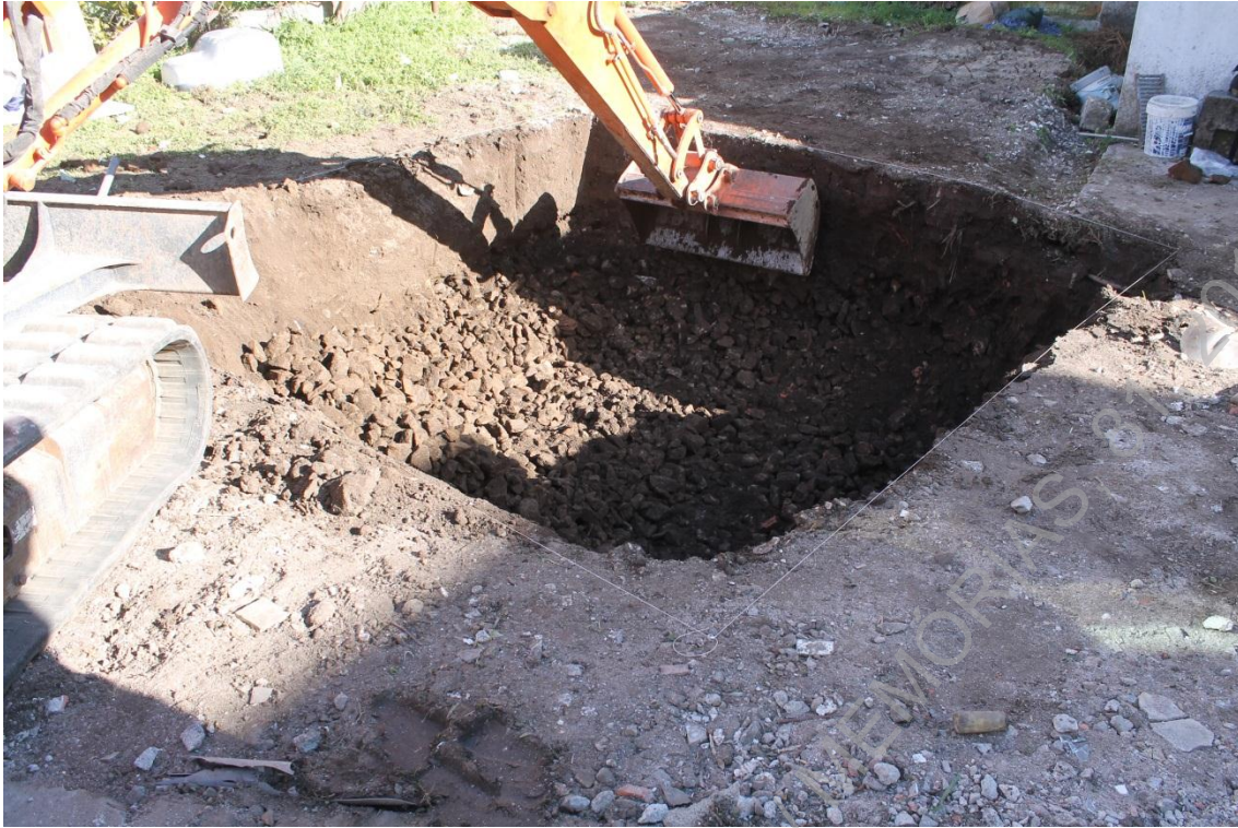
Foto 7 - (IMG_3129) - Aspeto intermédio de escavação (SO/NE).
