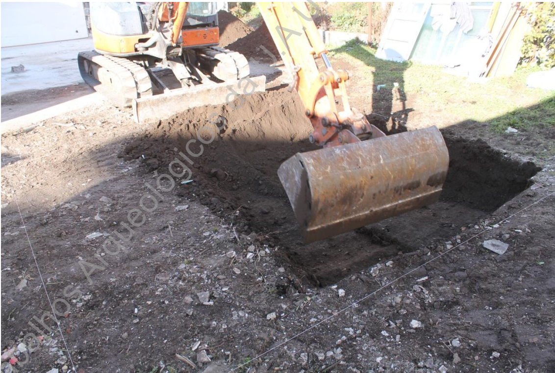
Foto 6 - (IMG_3123) - Aspeto intermédio de escavação (SE/NO).
