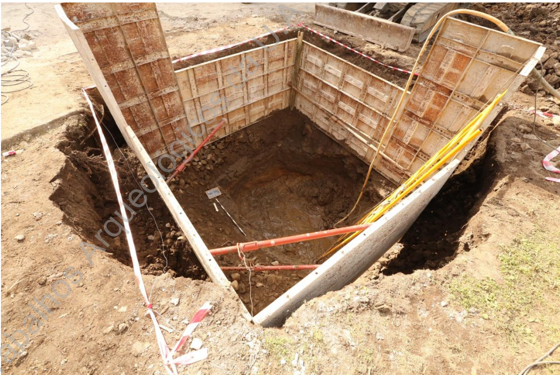
Foto 14 - (Z45A1425) – Aspeto do final da intervenção, (NE/SO).
