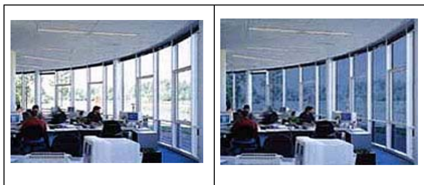
Figura 3.19 – Funcionamento de envidraçados electrocrómicos
