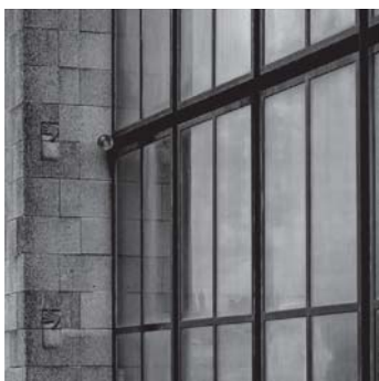
Figura 63 | Casa dos 24. Fotografia da autoria de © Mariam Daudali.
