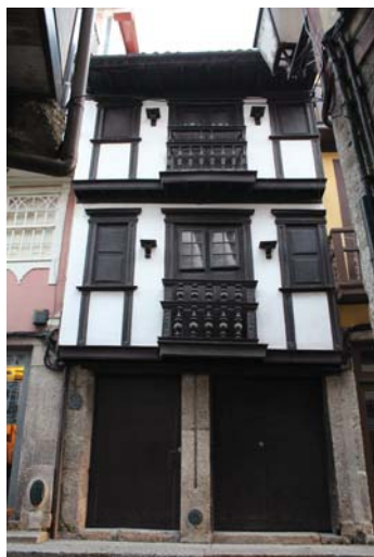
Figura 44 | Casa da Rua Nova. Fotografia de Raquel Alves.
