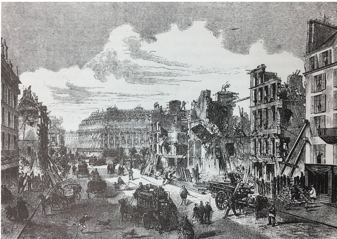
Fig.28 Autor desconhecido, Demolição para a abertura da Rue Réaumur, s/d.
