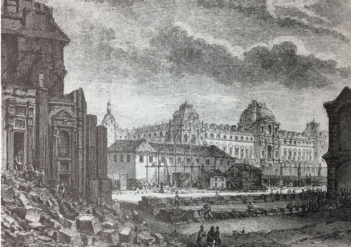
Fig.27 Autor desconhecido, Demolição do Pavillon de Flore, Paris, s/d.
