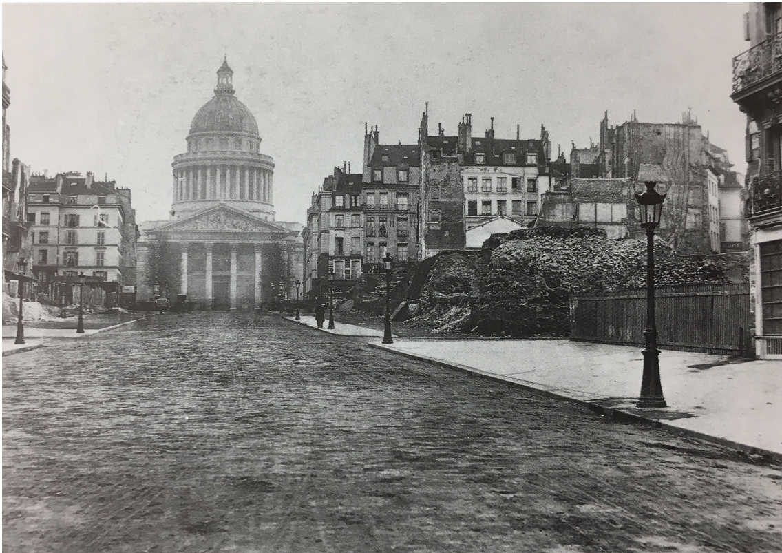
Fig.14 Autor desconhecido, Rue Soufflot durante o processo de demolições haussmannianas, s/d.
