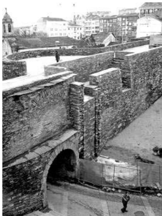
Figura 8 – Vista geral do sistema defensivo interno da Porta Miná, percebendo-se a porta de acesso, o arco da câmara superior sobre esta e o corpo de guarda no adarve com as duas entradas, bem como a escada de acesso geral que comunicaria com a contra porta inferior (Alcorta Irastorza, 1998: 43).
