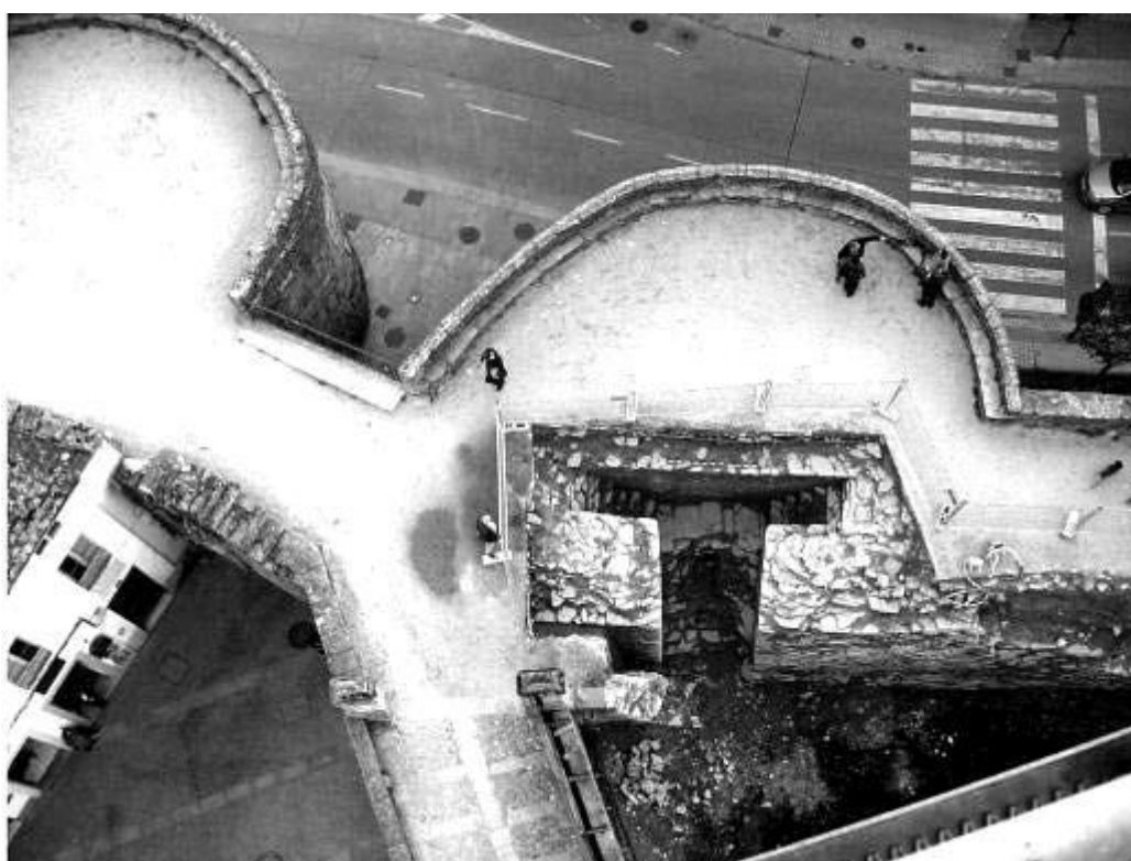
Figura 5 – Inserção da escada de acesso ao torreão 29, junto à Porta de Santiago (Alcorta Arastorza, 2008: 31).
