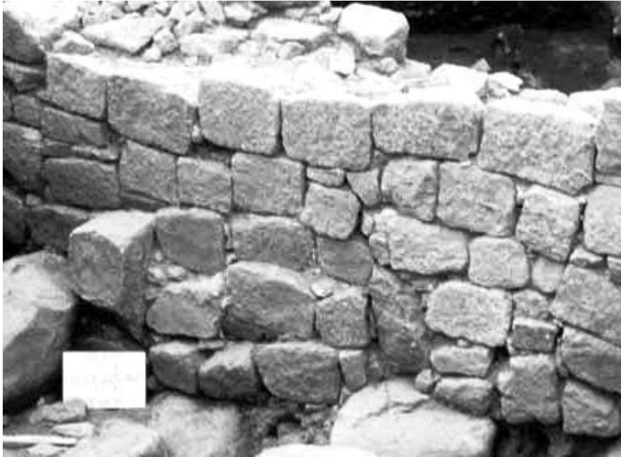
Figura 26 – Pormenor do paramento interno da muralha (©UAUM)
