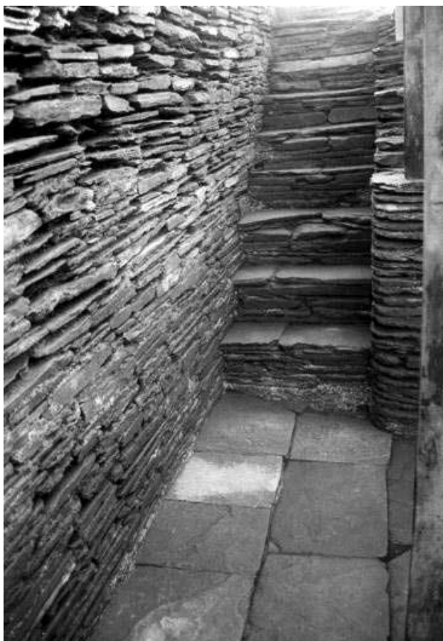
Figura 6 – Perspectiva interna da escada do torreão 51 (Alcorta Irastorza, 1998: 32).
