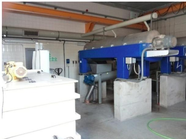
**Figura 14. Centrífugas de desidratação, com agregação da unidade de preparação de polímero da ETAR de Esposende.**
