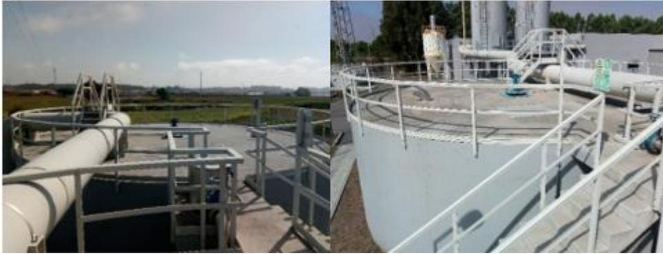
**Figura 13. Espessadores gravíticos de lamas da ETAR de Esposende.**
