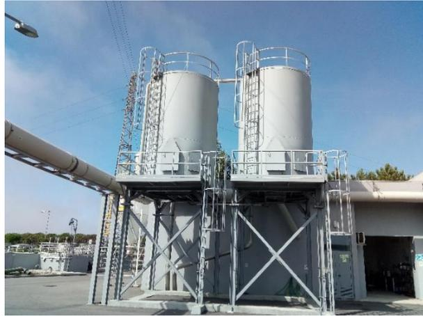
**Figura 15. Silos de armazenamento de lamas desidratadas da ETAR de Esposende.**
