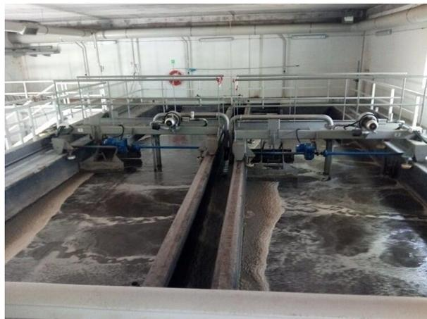
**Figura 9.** Órgãos de desarenamento e desengorduramento da ETAR de Esposende.
