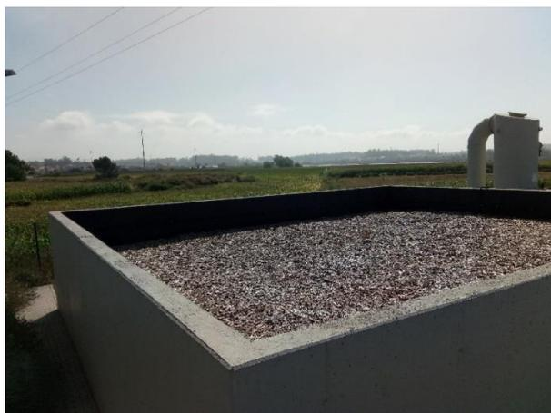
Figura 16. Biofiltro de estilha de pinho, associado à torre de desodorização da ETAR de Esposende.
