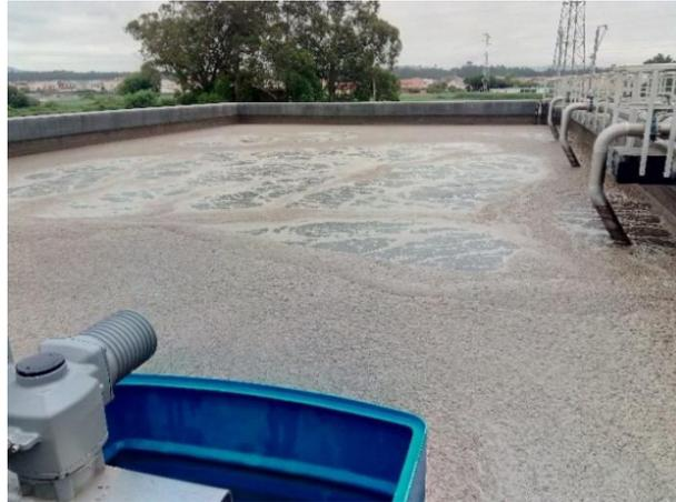
**Figura 11. Reator biológico do tipo SBR, em fase de arejamento, inserido na ETAR de Esposende.**
