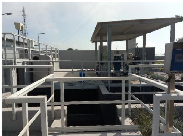
**Figura 12. Unidade de microtamisação e desinfecção do efluente tratado da ETAR de Esposende.**
