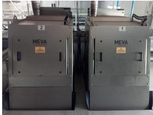
**Figura 8.** Stepscreens inseridos na etapa de gradagem da ETAR de Esposende.
