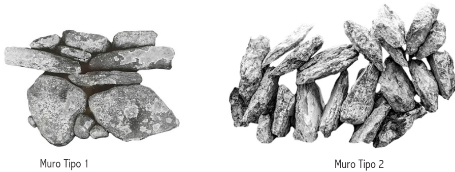
Fig. 35. Tipos de emparelhamentos de muros: o primeiro mais elaborado e o segundo sem qualquer regra.
