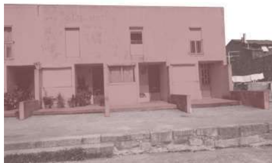
Figura 69 - Fotografia Projeto São Vctor - SAAL
