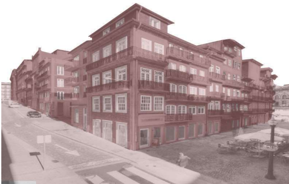
Figura 83 - Montagem Quarteirão das Cardosas
