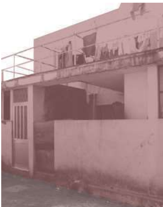
Figura 70 - Fotografia Projeto São Vctor - SAAL
