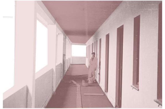
Figura 61 - Fotografia 1939 construção Bloco Duque de Saldanha
