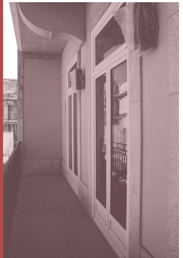
Figura 45 - Fotografia habitação Quarteirão das Cardosas - SRU
