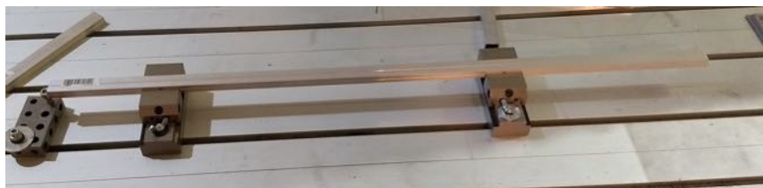
Figura 43. Corte e fabrico das barras de alumínio com fixação standard na CNC .
