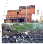
Queimada de resíduos diversos em vacante associado.
