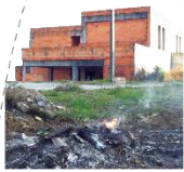
Queimada de resíduos diversos em vacante associado.
