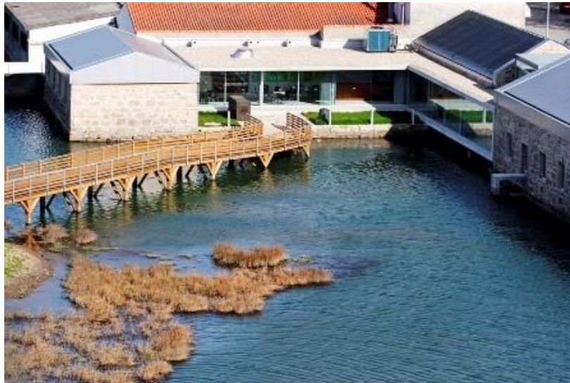
Figura 51 - Instalações do Centro de Monitorização e Interpretação Ambiental de Viana do Castelo.
