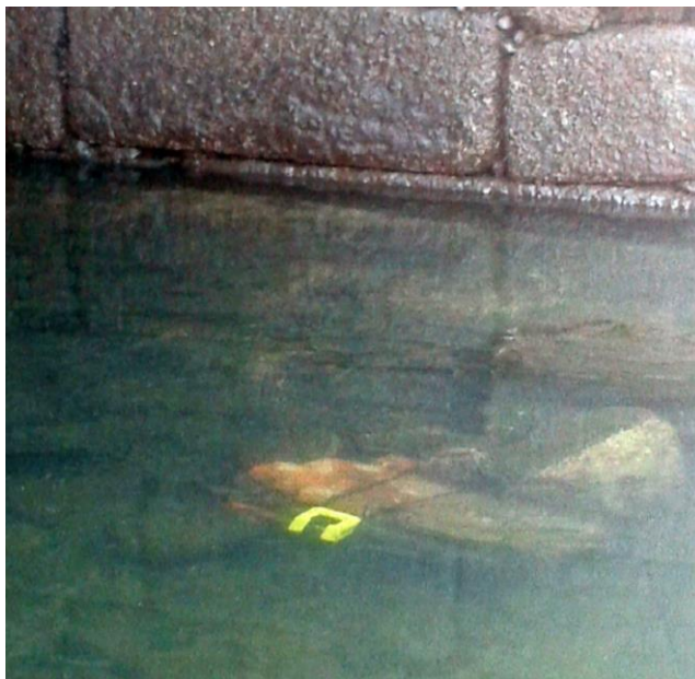
Figura 54 - Instalação do sensor em maré-baixa.
