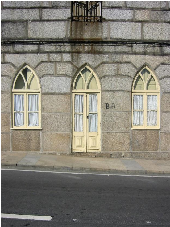
42 | Vista 02. 27 Ago 2009. 10h32.
