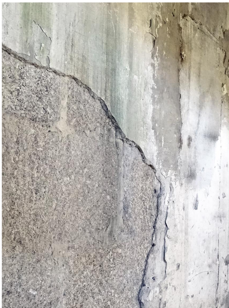
84 | Parede resistente (interior) de alvenaria de pedra. Fotografia. 28 Set 2017. 09h24.
