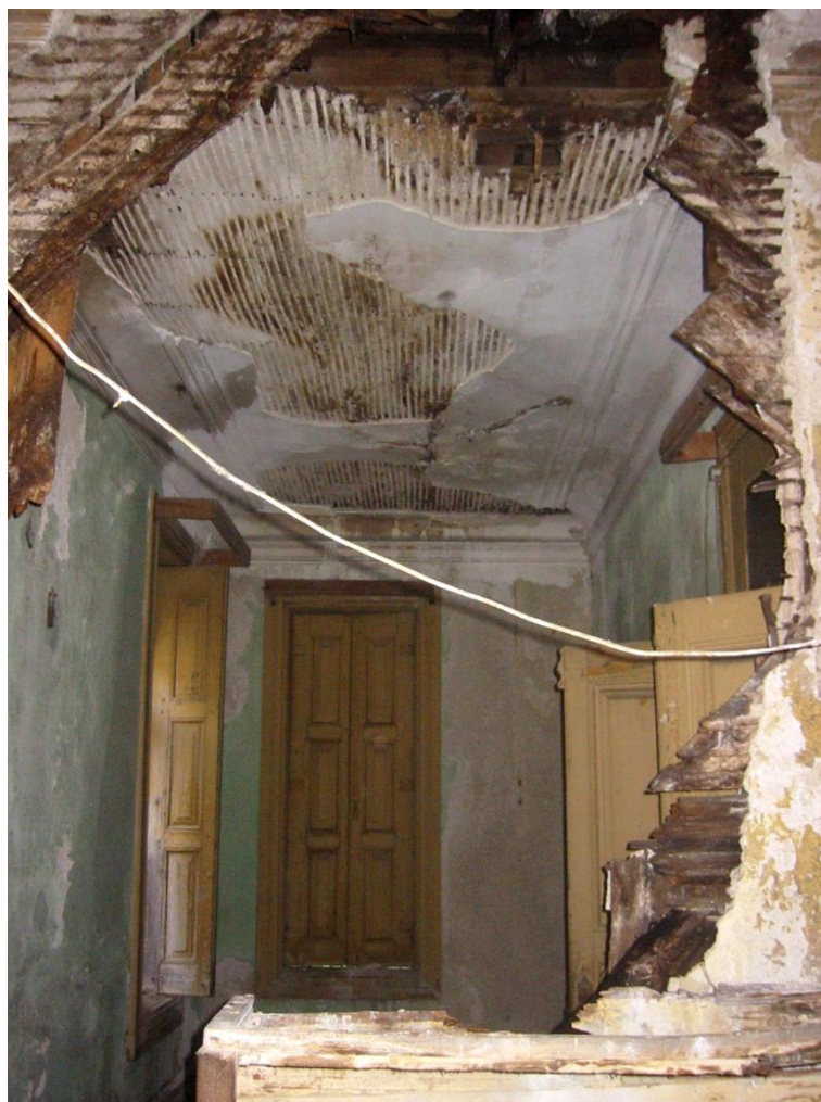
87 | Parede de compartimentação de tabique simples. Fotografia. 03 Out 2007. 15h39.
