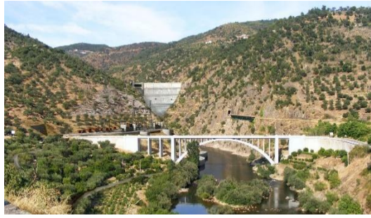
163 | Edifício de Aproveitamento Hidroelétrico de Foz Tua.
