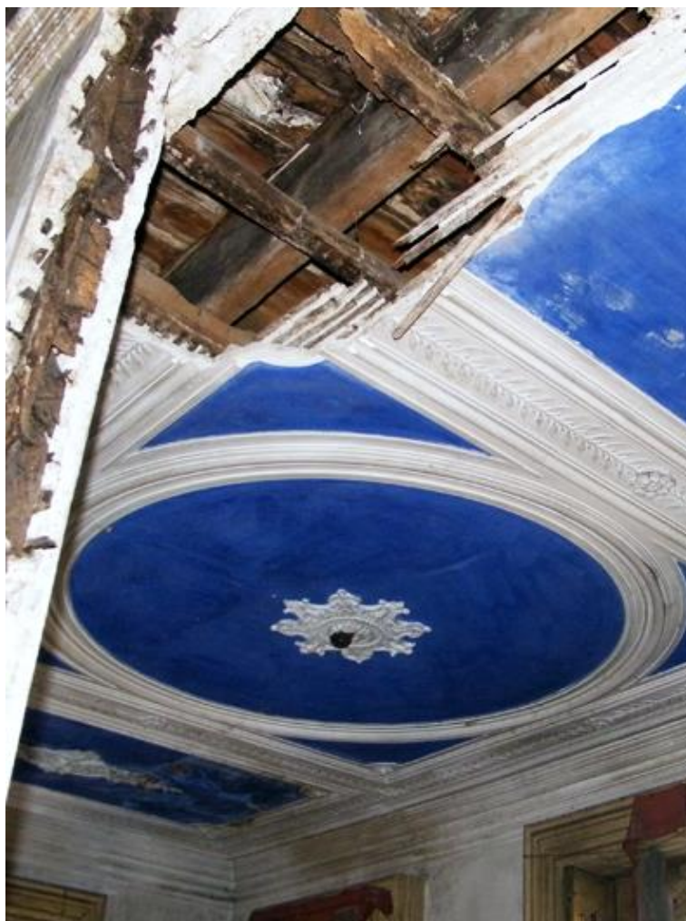
90 | Pavimentos. Fotografia. Maio 2012 (?).
