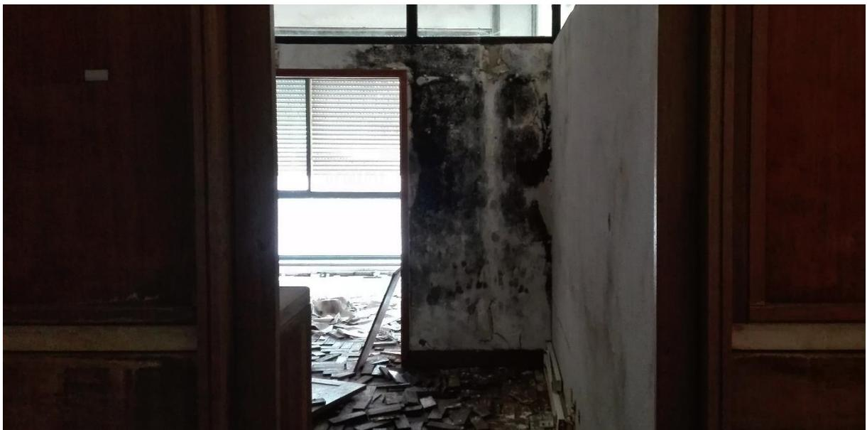
*Figura 36.1 – Levantamento fotográfico de patologias que derivam de humidades*
