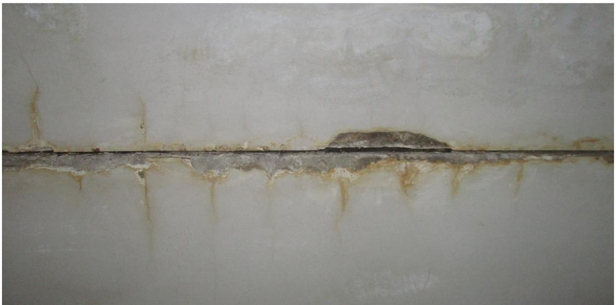
*Figura 36 – Levantamento fotográfico de patologias que derivam de humidades*
