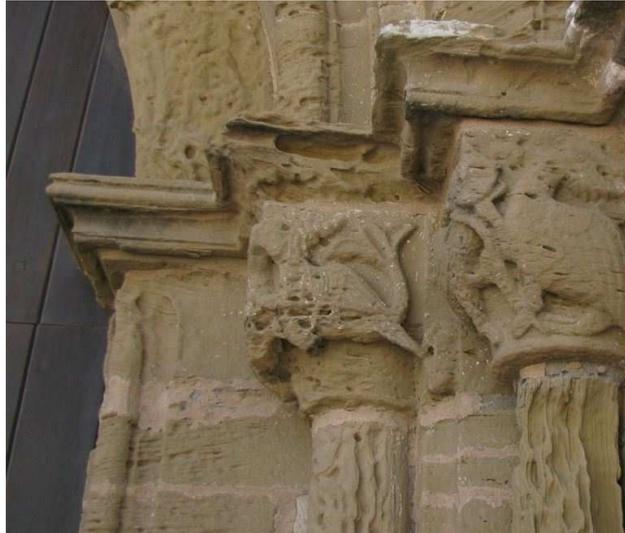
Figura 5 – Padrões de erosão de pedra sedimentar associados com estratificação
