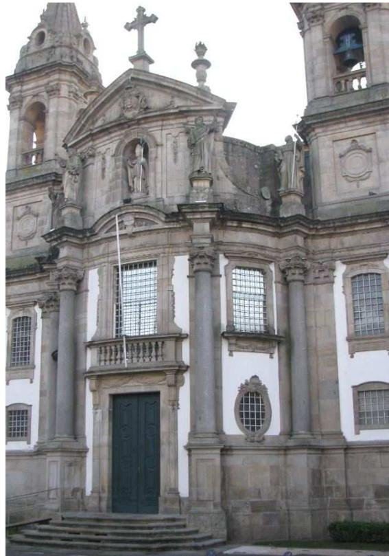
Figura 4 – Exemplo de colunas monolíticas de grande dimensão em granito (Braga).
