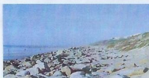
Foto 1 - O impacte do enrocamento sobre a morfodinâmica da linha de costa
