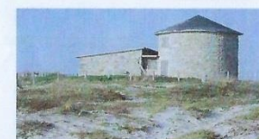
Foto 4 - Moinho a alguns metros de praia da Apúlia, sujeito à erosão costeira
