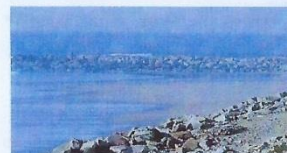
Foto 3 - Esporão construído a 1.700 m da praia da Apúlia
