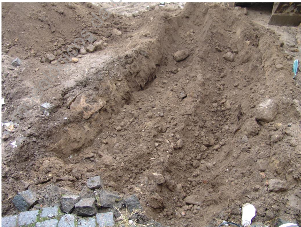
Foto 4 Sond. 1, início desaterro mecânico, orientação NO/SE
