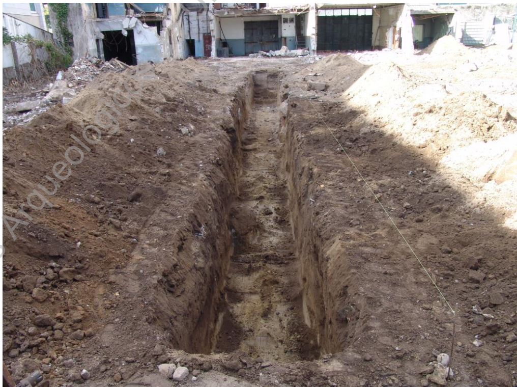
Foto 12 Sond. 2, perspectiva final após desaterro, orientação S/N
