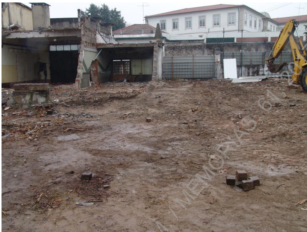
Foto 3 Vista Sond. 1, antes da intervenção, orientação S/N
