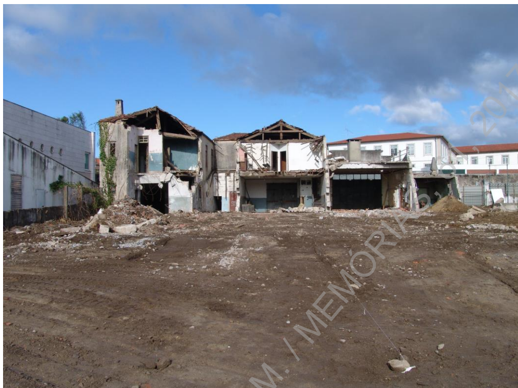
Foto 9 Vista Sond. 2, antes da intervenção, orientação S/N
