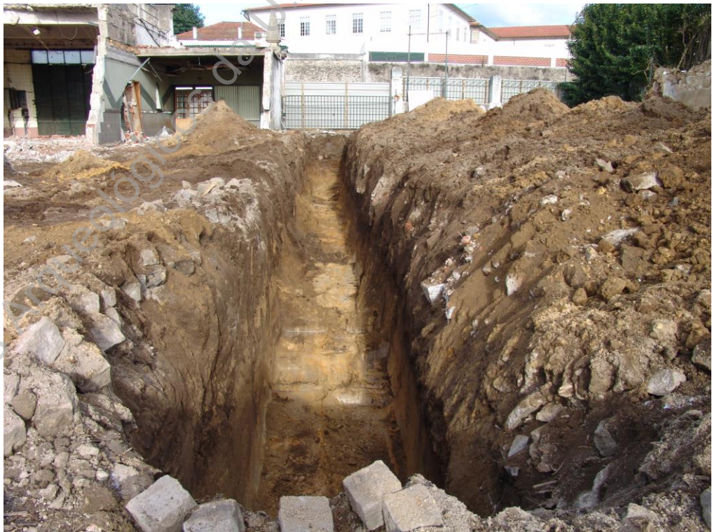
Foto 8 Sond. 1, perspectiva final após desaterro, orientação S/N
