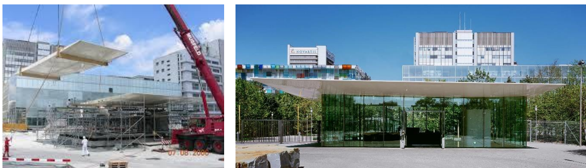
Figura 2.13 - Instalação do painel compósito da cobertura e aspeto final do edifício (CCLAB).
