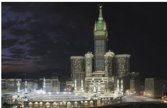
Figura 2.16 - A Makkah clock tower, torre central do Abraj-al Bait (Makkah, KSA). Edifício com 607 m em que os últimos 200 m contém mais de 40000 \text{ m}^2 de painéis sanduíche compósitos e FRP, incluindo o maior relógio do mundo (com 47 m de diâmetro) (Gurit, 2012).
