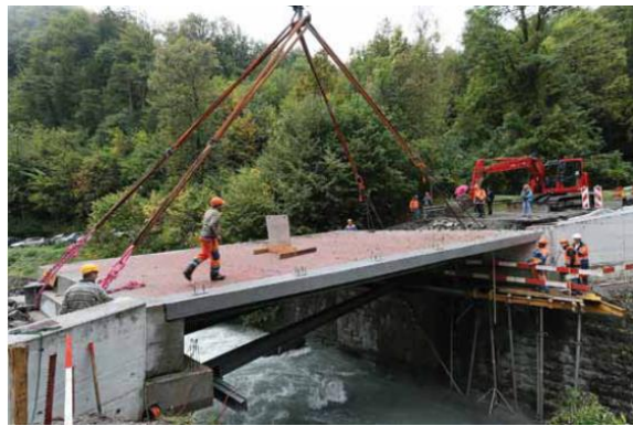
Figura 2.15 - Ponte sobre o rio Avançon (vão com 11.4 m) (Flynn, 2013).
