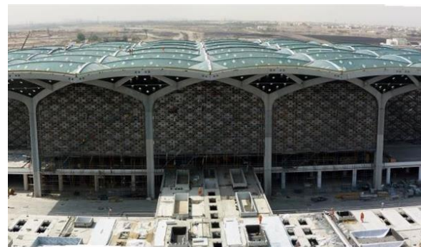
Figura 2.17 - Cobertura da estação Haramain High Speed Rail. O telhado é estruturalmente composto por uma estrutura compósita com faces em GFRP e núcleo em PET. Os vãos possuem até 9 m e cobrem 160000 \text{ m}^2 (Gurit, 2013).
