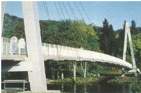
Figura 2.40 - Ponte Aberfeldy- Primeira ponte pedonal 100% compósita (1992) (Correia, 2004).
