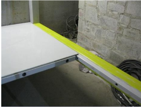
Figura 2.9 - “Clickhouse”: painéis sanduíche compostos por lâminas em GFRP e núcleo em PUR. Estes foram utilizados para piso, parede e teto e foram produzidos por moldagem manual. Vãos até 3 m e sobrecarga de 1.6 kN/m 2 .
