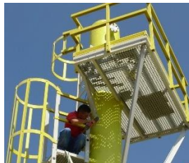
Figura 2.37 - Plataforma de trabalhos com escada isolante e guarda-corpo (ALTO).
