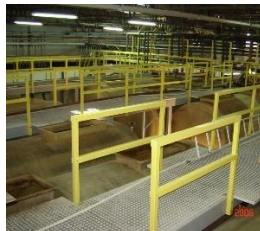
Figura 2.36 - Passadiços em gradil com guarda-corpos (ALTO).
