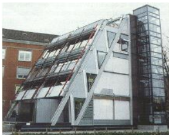
Figura 2.42 - FRP Edifício EyeCatcher (1999) (Correia, 2004).
