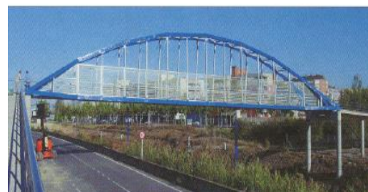
Figura 2.43 - Ponte Lérida (2001) (Correia, 2004).
