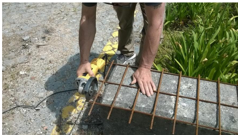
Figura 5.33 – Marcação e corte da malha sol.
