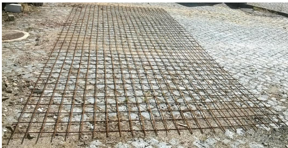
Figura 5.32 – Malha sol de \phi 8//0,100 transversalmente e de \phi 6,5//0,150 longitudinalmente.
