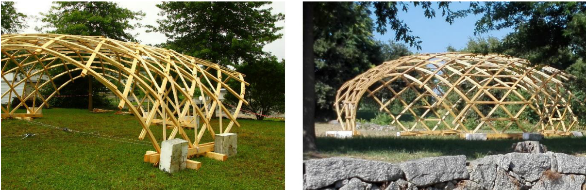
Figura 133 - Alteração da posição dos travamentos
