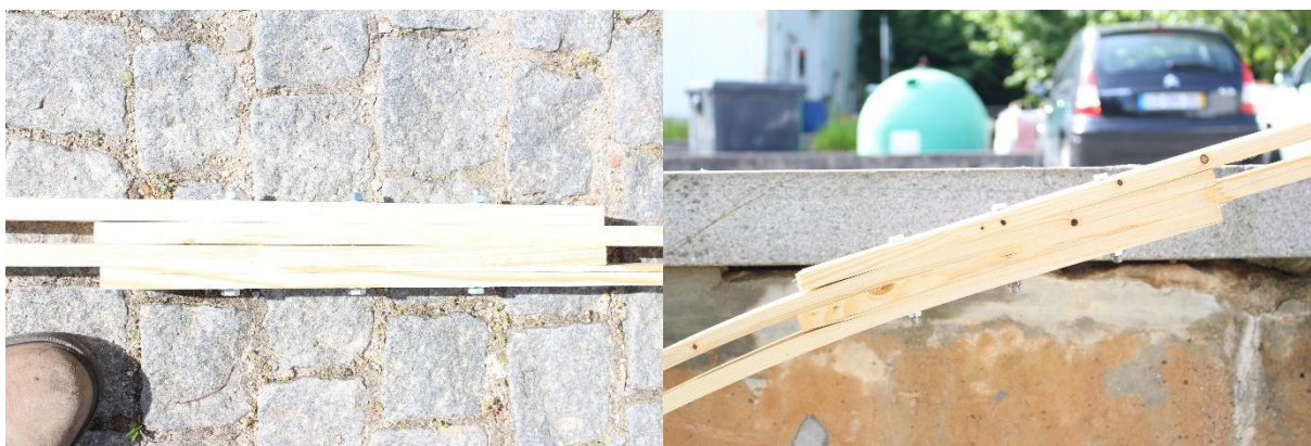
Figura 108 - Ligação demasiado rígida
