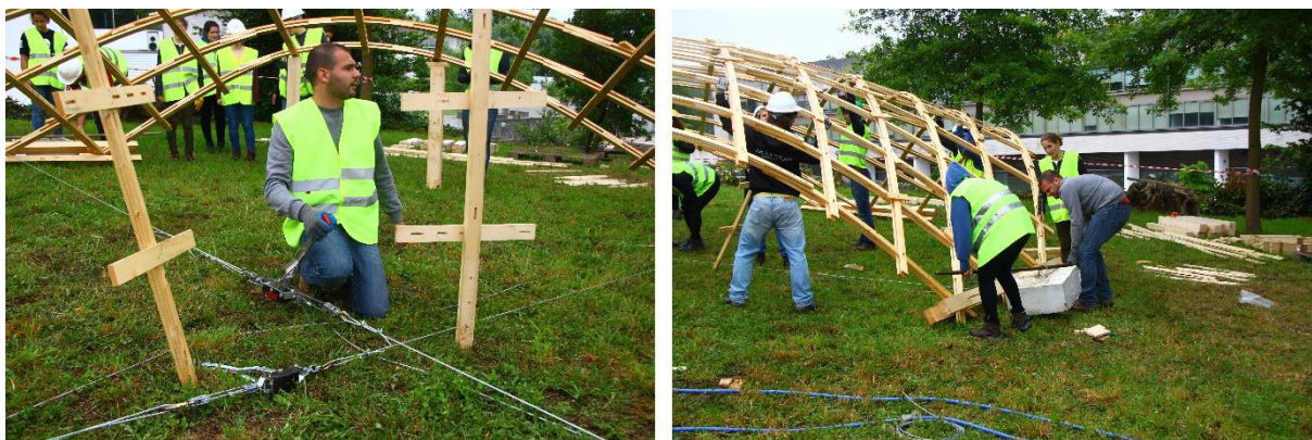
Figura 128 - Utilização do sistema de cabos e recolocação dos elementos de betão
