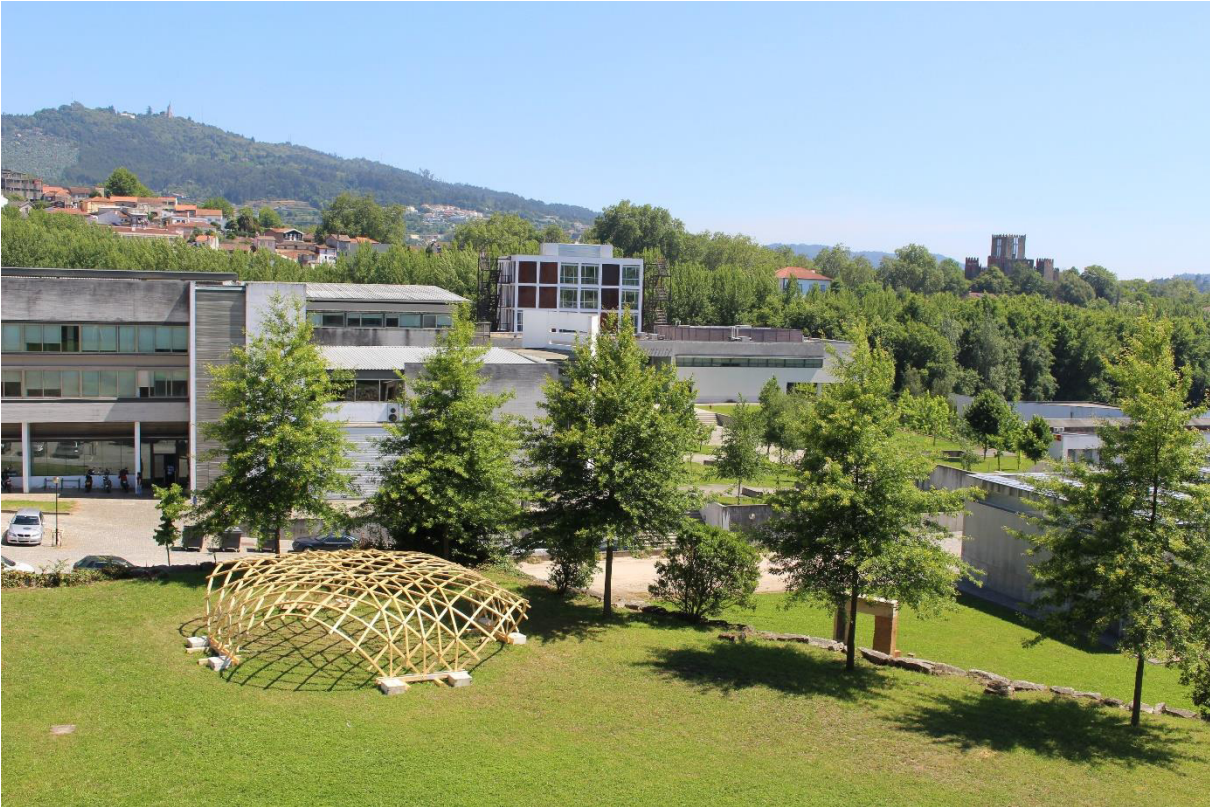
Figura 136 - Primeira malha estrutural em madeira, de que há registo, em Portugal. Campus de Azurém, Universidade do Minho, Guimarães
