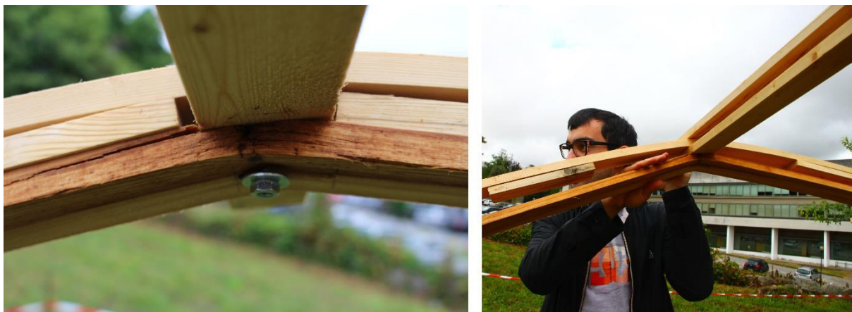
Figura 131 - Rotura de duas ripas de madeira
