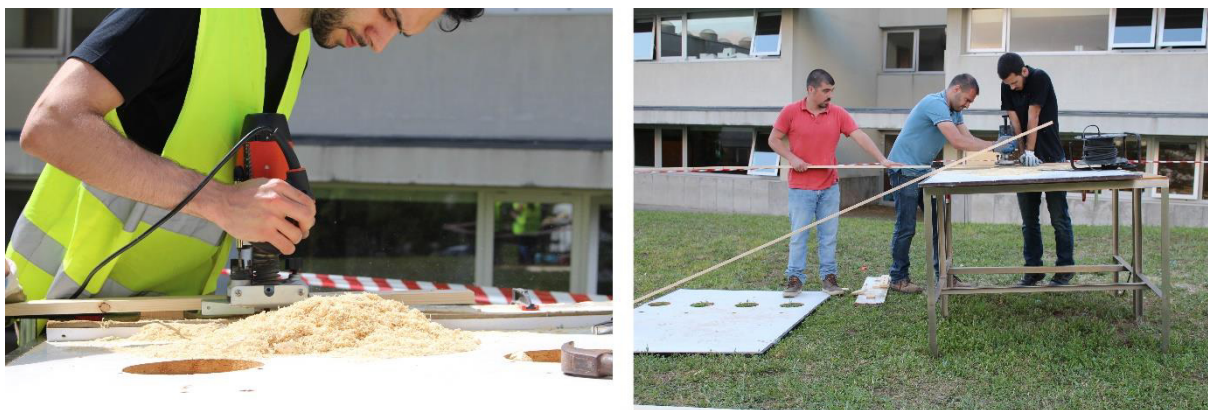
Figura 119 - Furação dos elementos de madeira
