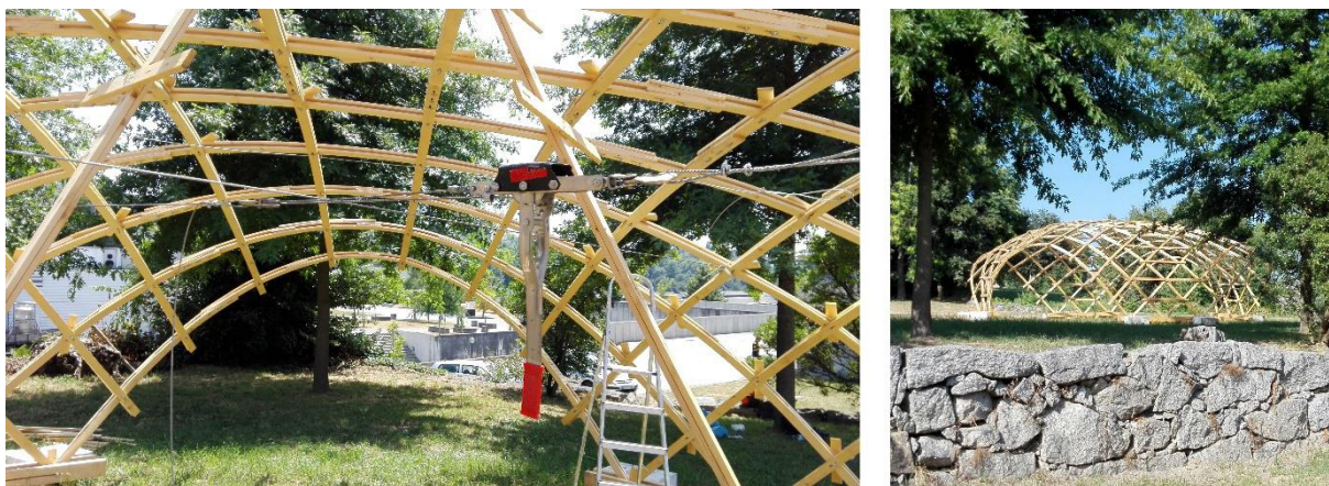
Figura 135 - Aplicação de cabo no interior da estrutura
