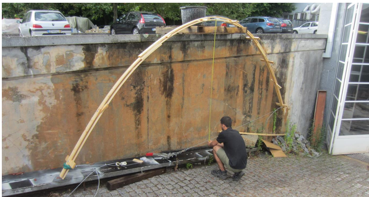
Figura 109 - Arco deformado com a altura desejada
