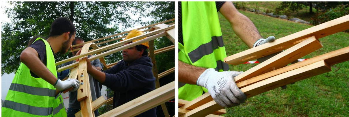
Figura 132 - Substituição dos elementos danificados
