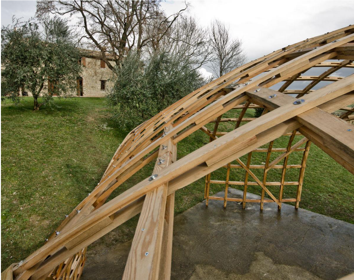
Figura 17 – Malha estrutural de layer duplo “Alida Woodome” (Gridshell.it, 2016)
