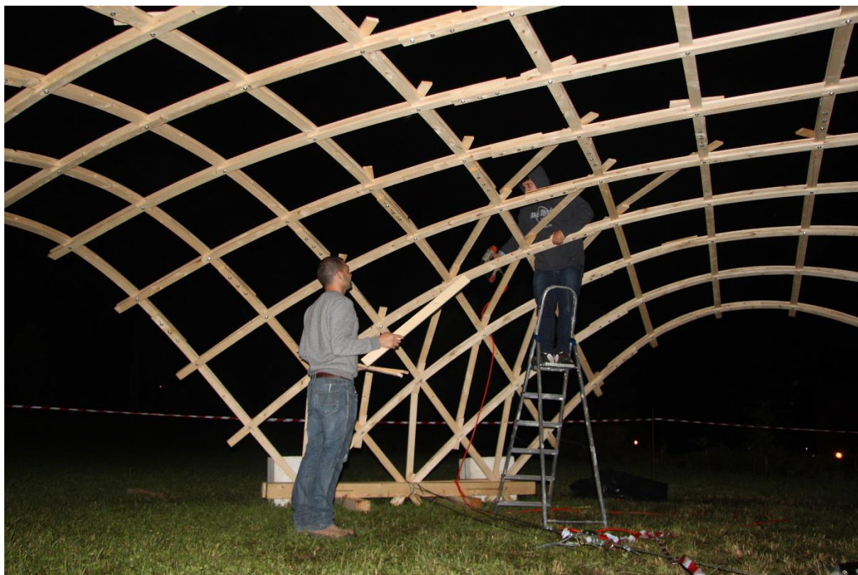
Figura 130 - Aplicação de travamentos com pistola de pregos
