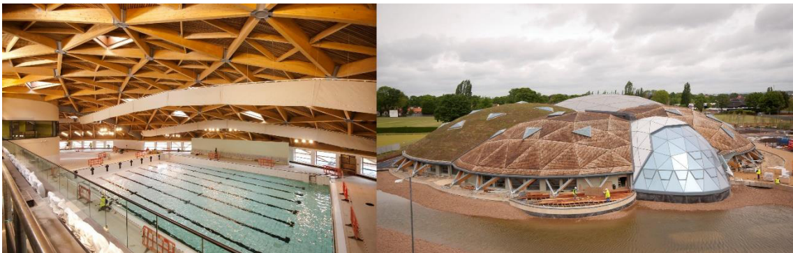
Figura 3 - Malha estrutural de elementos descontínuos, The Pod Sports Complex (Archello Site, 2015)
