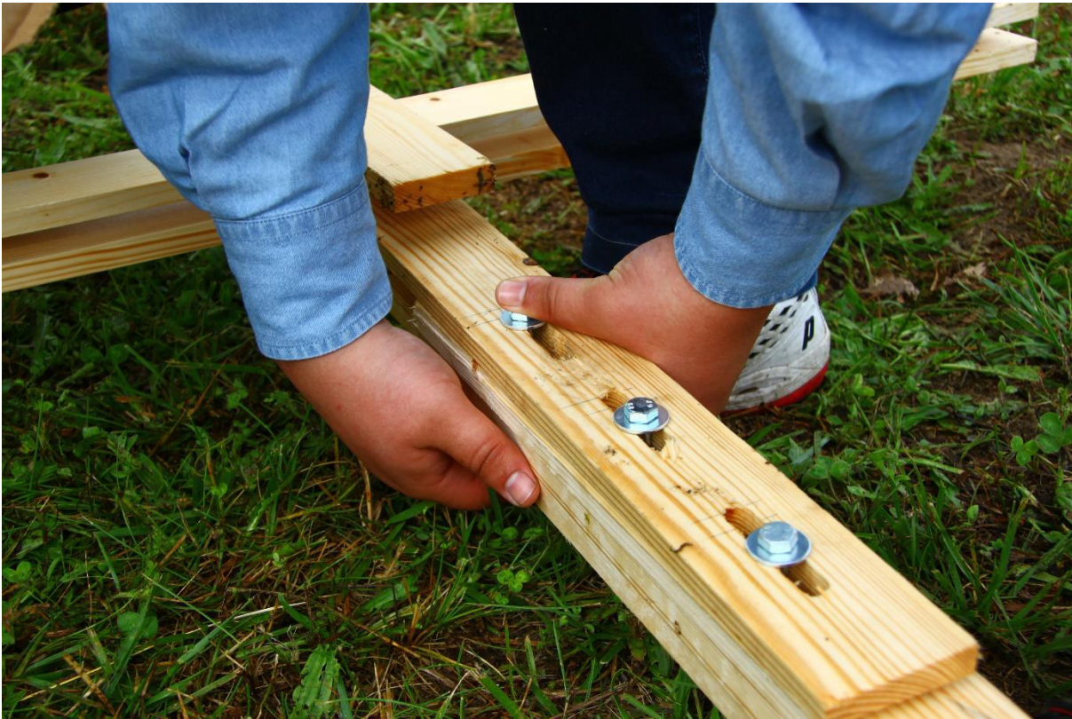
Figura 121 - Ligação de continuidade
