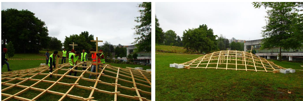
Figura 126 - Elevação manual da malha e aplicação de escoras
