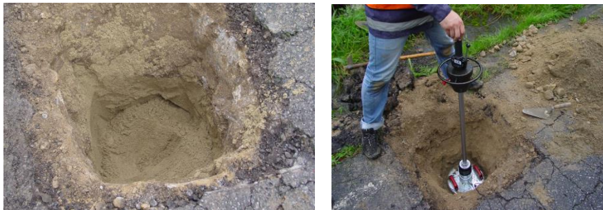
Figura 25 - Exemplo da abertura de poço e realização de ensaio de capacidade de carga
