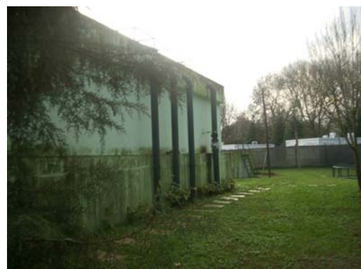
Figura 8 – Tanque Imhoff da ETAR de Ponte de Lima (vista lateral).
