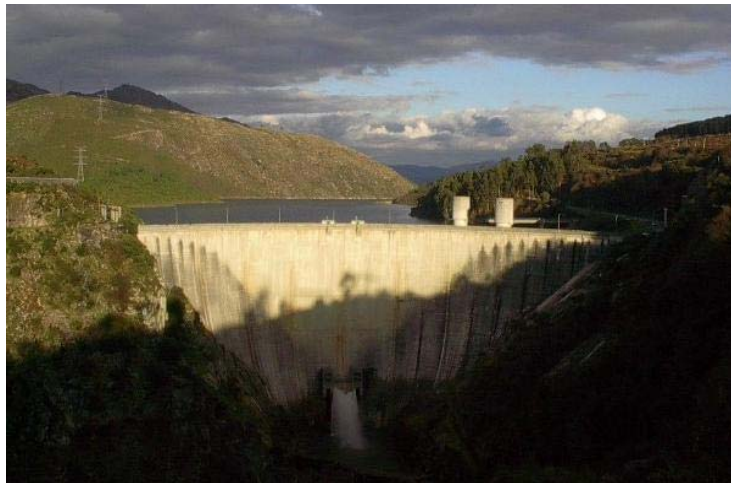
Figura 5 – Barragem do Alto Lindoso.
