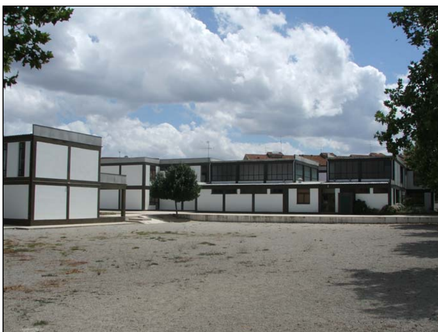
Os dois edifícios da escola
