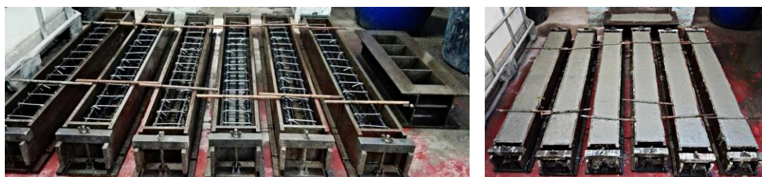
Figura 69 - Betonagem vigas
