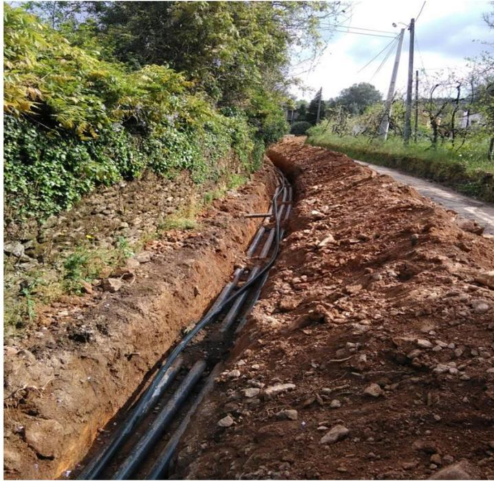
*Figura AVIII 3: Novas condutas colocadas na*
