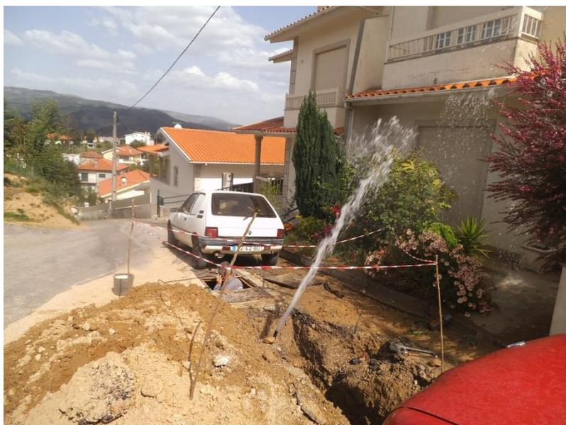
*Figura AIV 1: Rotura accidental de conduta principal por falta de cadastro actualizado.*
