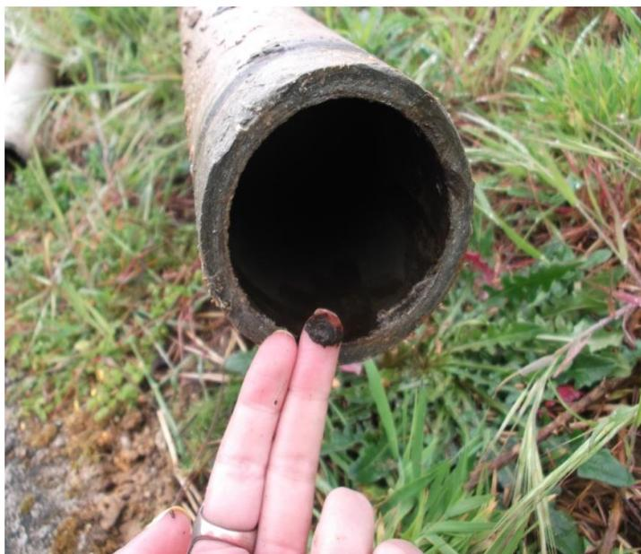
*Figura AVIII 1: Conduta de fibrocimento retirada da rede.*
