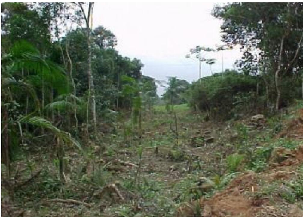
Figura 5.3: Supressão da vegetação na faixa de servidão (Fonte: Eletrosul Centrais Elétricas S.A., 2002).
