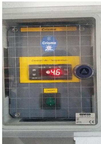
Figura 24 - Controlo de Temperatura da Câmara de refrigeração do prestador *Fátima Sanchez*
