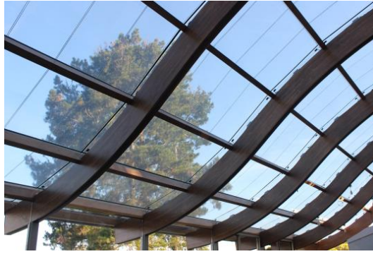
Figura 2.7 - Módulos solares fotovoltaicos integrados na fachada de um edifício [34].
