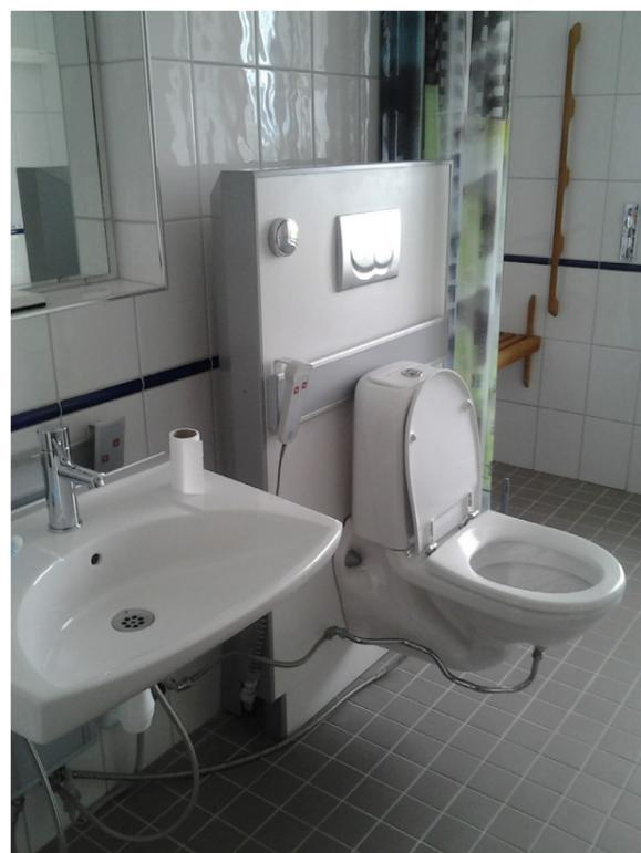
Fig.37: Sanita ajustavel em altura
