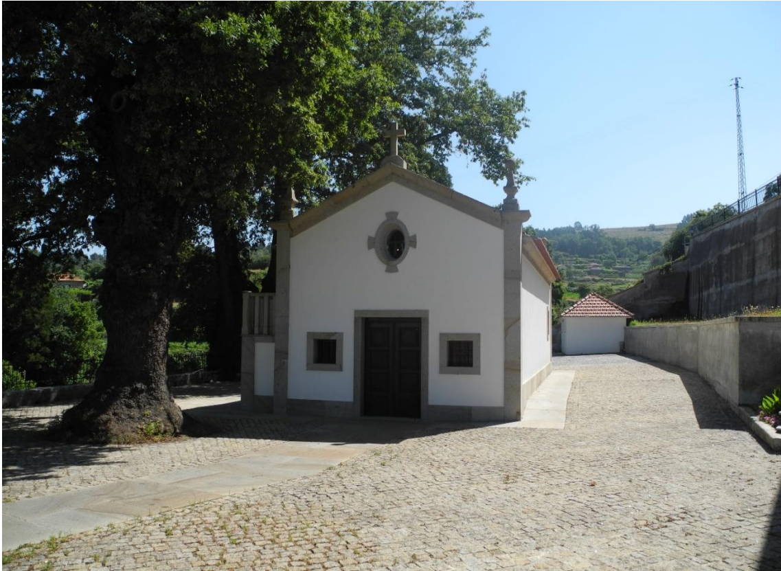
Recinto exterior da Capela de S. Pedro de Meca.
