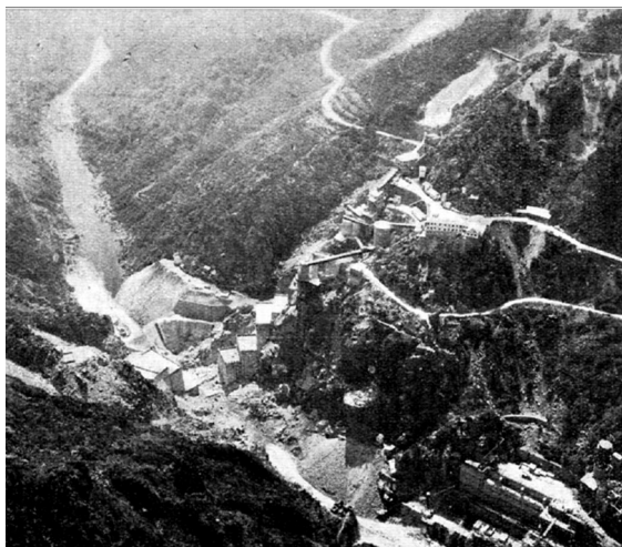
Fig. 11 - Fotografía área de las obras de la presa de Santo Estevo en 1953 (Tomada de M. Almagro Basch, 1954).
