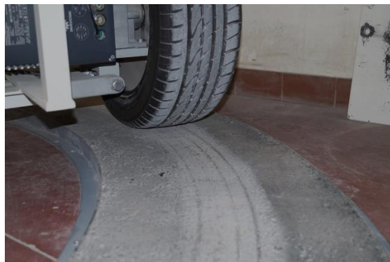
Figura 4: Superfície resultante da aplicação do slurry seal
