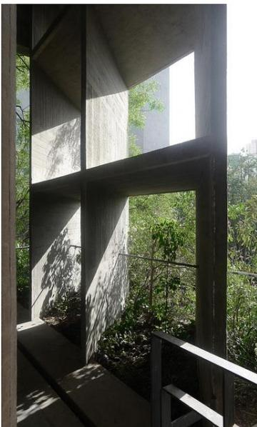
**Fig. 77.** Lâminas diagonais do brise da fachada oeste
