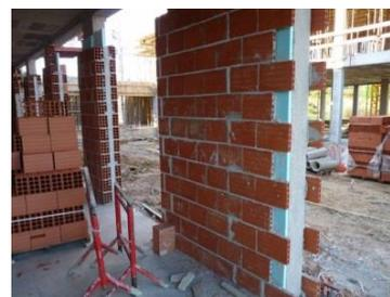
**Fig. 22.** Paredes construídas em tijolo cerâmico
