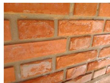
**Fig. 30.** Manchas por eflorescências e descolamento do revestimento de tijolos
