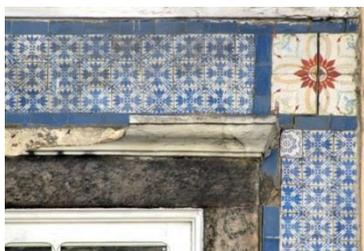
**Fig. 17.** Revestimento de uma fachada em faiança
