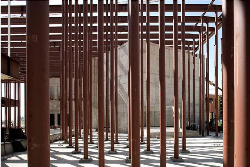
**Fig. 170.** Pilares metálicos antes da colocação do revestimento em cerâmica
