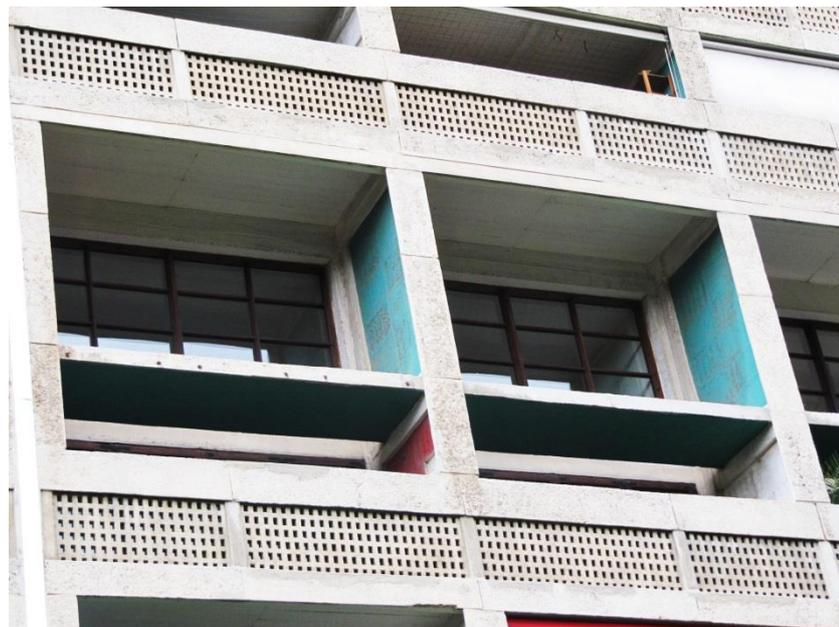
**Fig. 91.** Grelhas de ventilação no *brise soleil*
