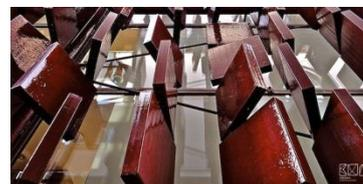
**Fig. 136.** Peças cerâmicas que formam a fachada
