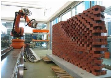
**Fig. 113.** Construção da parede por braço robotizado
