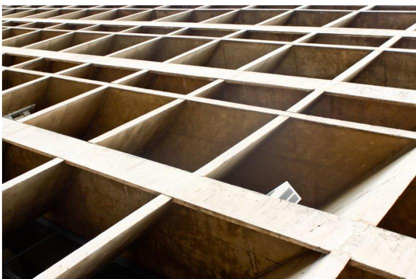
**Fig. 95.** Pormenor do direcionamento das lâminas do *brise soleil*
