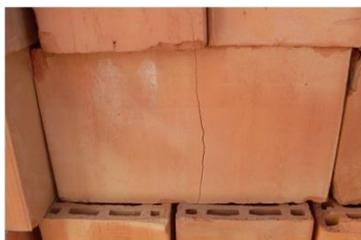
**Fig. 28.** Fissuramento numa peça cerâmica
