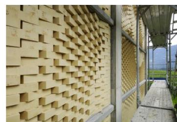
**Fig. 120.** Pormenor do assentamento dos tijolos em fase de obra
