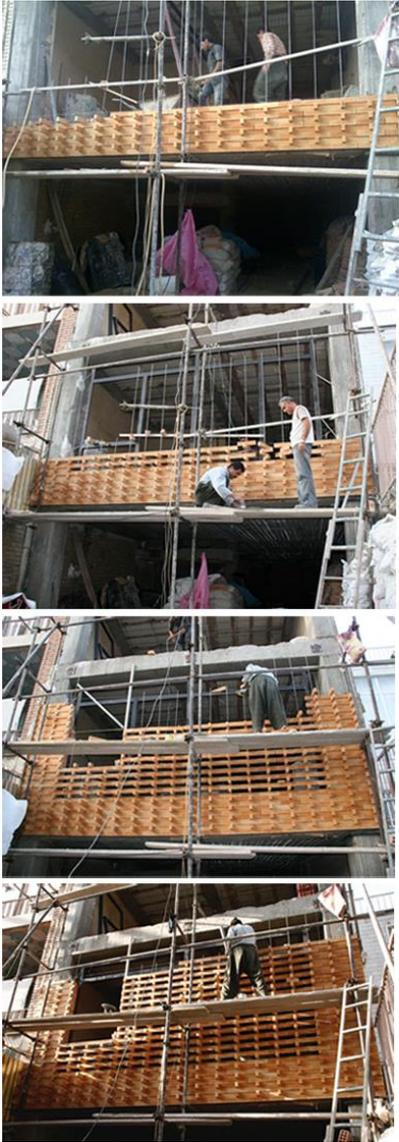
**Fig. 184.** Encaixe entre tijolos e montagem da fachada durante a obra
