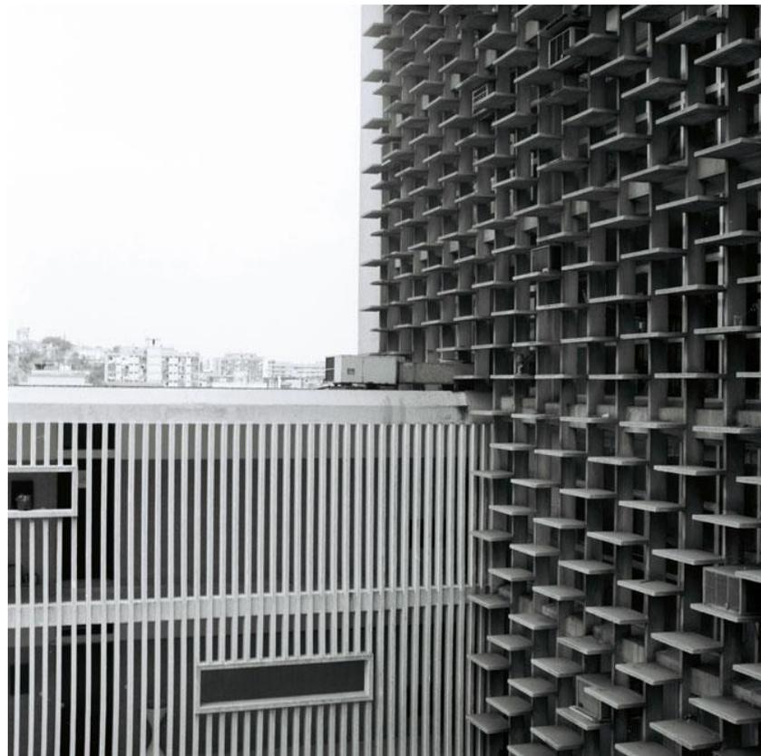
**Fig. 83.** Fachada *brise soleil* sul composta por palas horizontais
