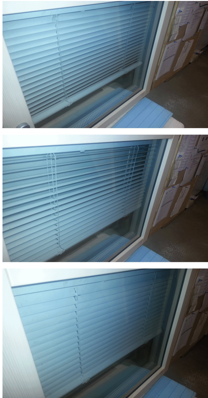
Figura 6.9: Demonstração de diferentes inclinações das folhas da persiana da janela Climawin . De cima para baixo: inclinadas para o lado de fora, horizontal e inclinadas para o lado de dentro.
