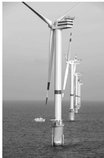
Figura 2.19 – Turbinas eólicas usadas num sistema off-shore [9].
