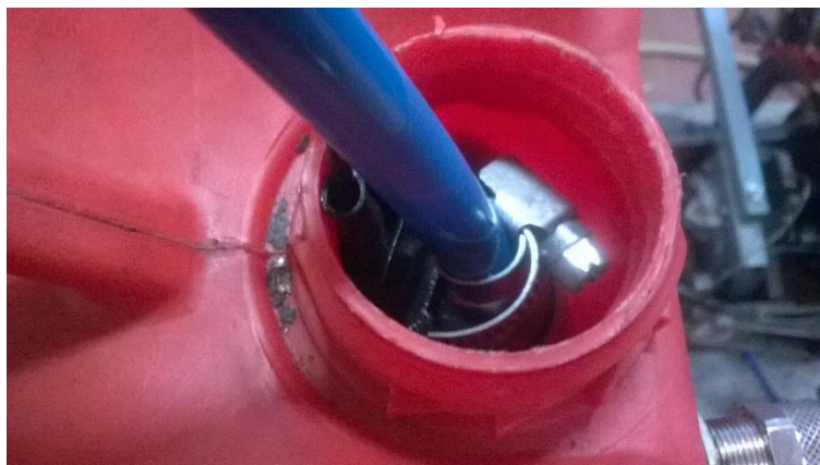
Figura 191 - Bomba de combustível com abraçadeira
