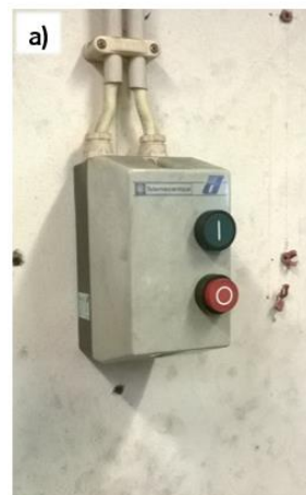
Figura 57 - a) Interruptor do ventilador do permutador; b) Conduto do ventilador do permutador
