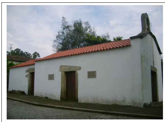
Fig. 113 - Capela de S. Tiago na atualidade, Remelhe.
