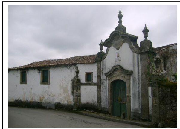
Fig. 111 - Fachada da Casa de Santiago, na atualidade.
