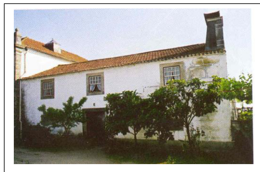
Fig. 116 - Casa do Sousa, Remelhe.
