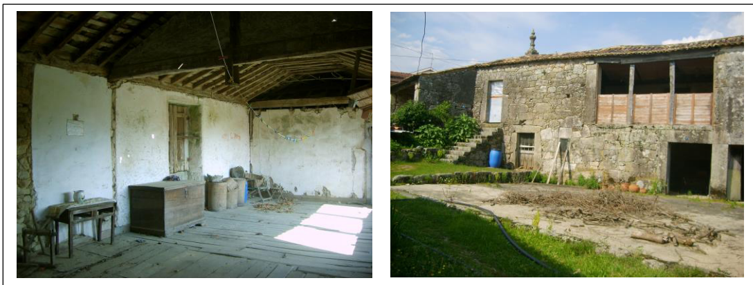
Fig. 144 - Anexos da Casa de Santiago, Remelhe.
