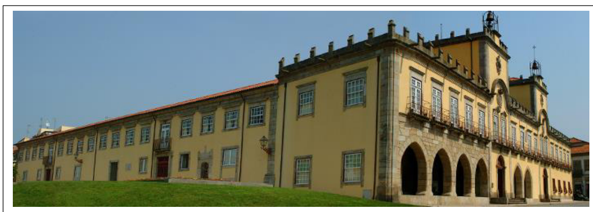
Fig. 3 - Edifício atual da Câmara Municipal, Barcelos. Na fachada da esquerda, funcionava o Hospital do Espírito Santo (século XIV).
