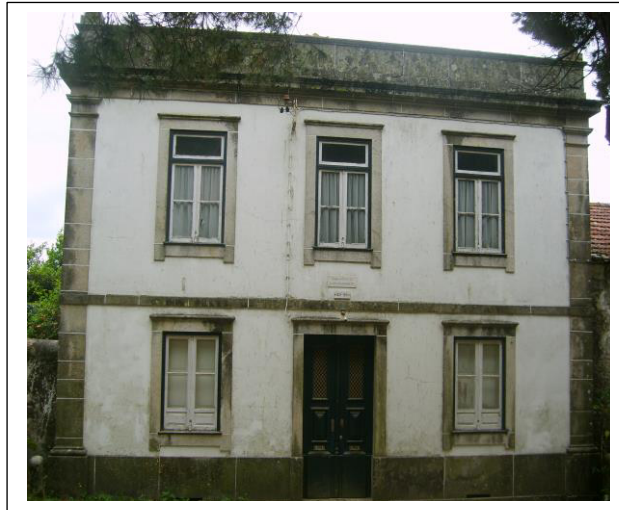
Fig. 153 - Fachada da casa de D. António Barroso.
