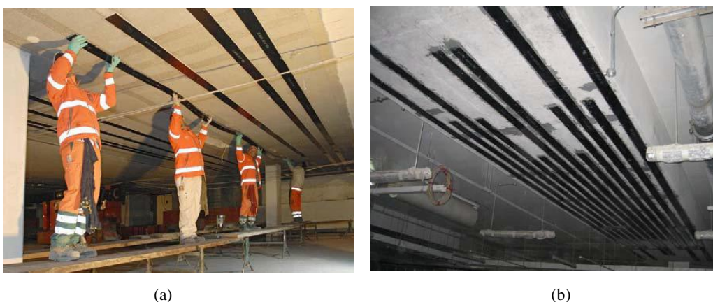
Figura 2.14 (a) Pormenor de aplicação de Laminados; (b) Reforço por adição de laminados (Carvalho 2010).
