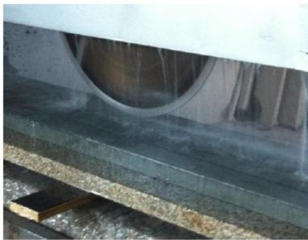
a) Execução das ranhuras:
