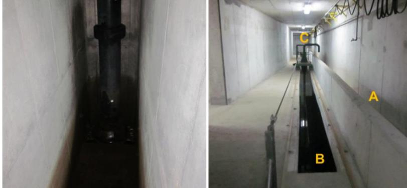
**Figura 37** – Reservatório de aspiração.
