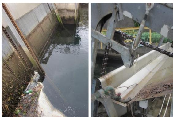
**Figura 26** – Grelha de ligação à conduta forçada/elevatória e Túnel do Covão.
