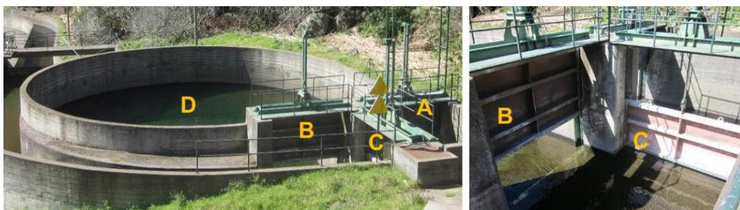
**Figura 14** – Estrutura de sedimentação.
