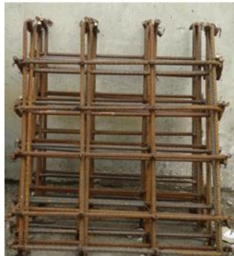
b) Armadura com 10 mm de diâmetro
