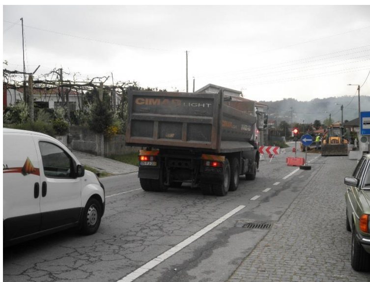
Figura 66 – Sistema semafórico em obra
