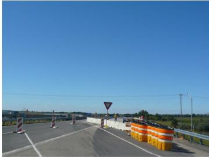
Figura 17 – Obstruções em zonas de obras (Sinais e equipamento)
