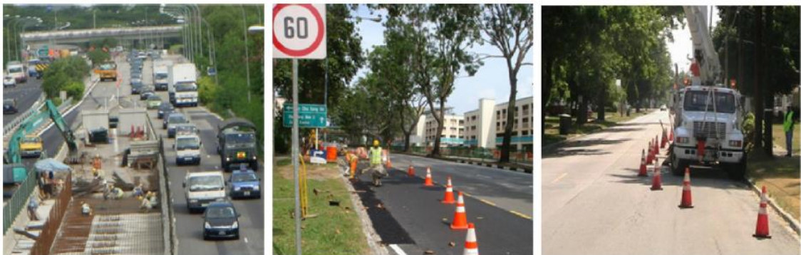
Figura 15 – Imagens representativas de uma obra de construção, conservação e trabalhos rápidos, respetivamente (Weng and Meng 2011)
