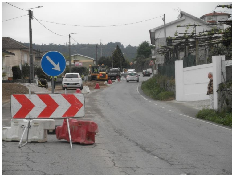
Figura 55 – Área adjacente à faixa de rodagem (Obra CJR)
