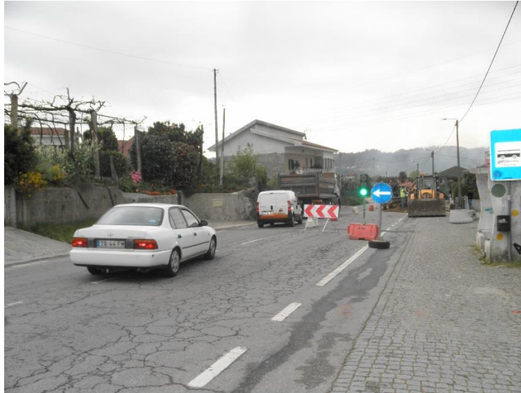
Figura 67 – Sistema semafórico em obra
