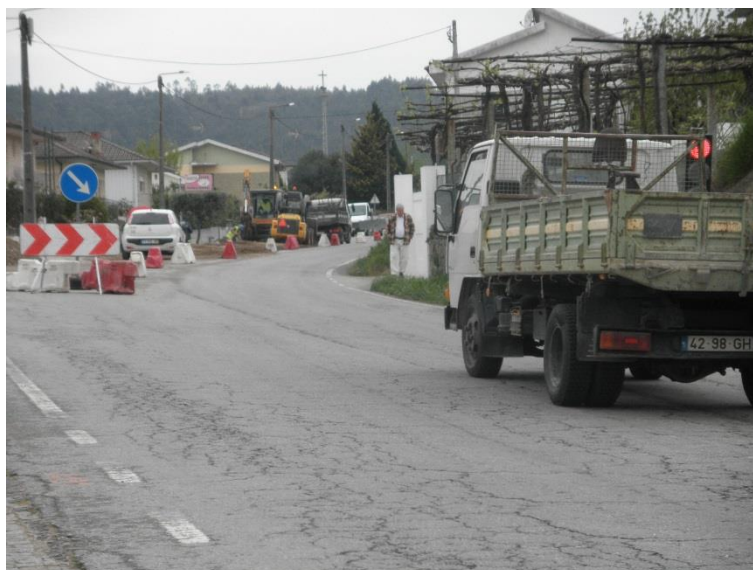
Figura 65 – Sinalização em obra (Sinais CT4 e ET2)
