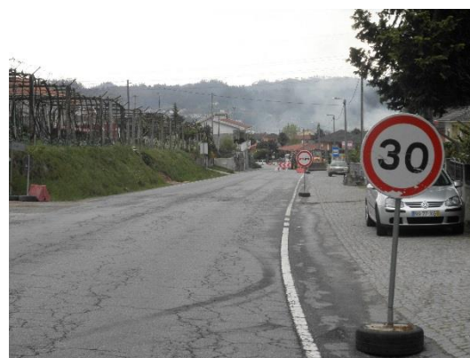
Figura 64 – Sinalização em obra (Sinais C13 e C14a)
