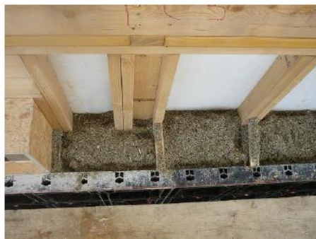
Fig. 10 - Exemplo método de compactação (M.Santos, 2013)
