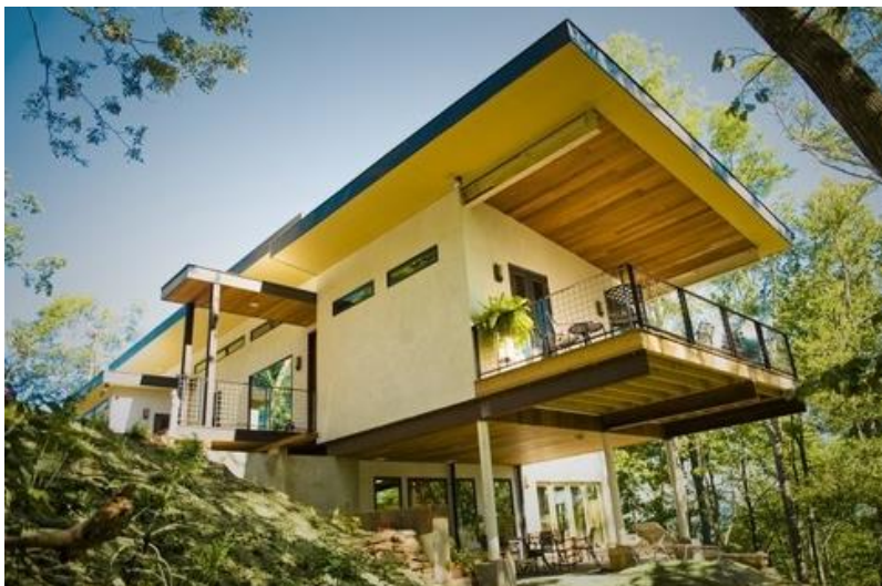
Fig. 13 - Casa construída em cânhamo, E.U.A (E.Pegurier, 2010)
