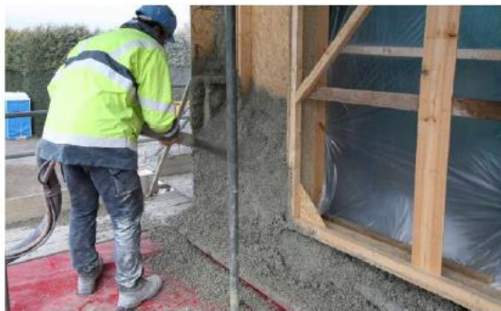
Fig. 11 - Exemplo do método de pulverização (M.Santos, 2013)
